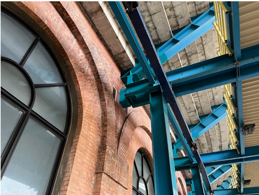
Figure 161: Détail de jonction ancien - nouveau
