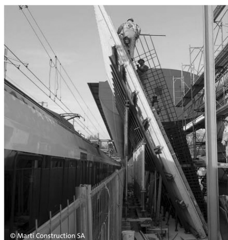
Le coffrage, rigidifié au moyen de profilés métalliques, se prolonge par dessus le gabarit de la voie CFF contiguë
