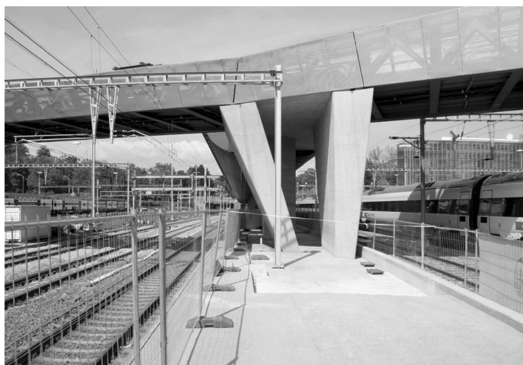
Coup d'œil sur le quai, sur lequel se dresse l'appui central de la passerelle, comportant deux piles: l'une verticale et l'autre inclinée
