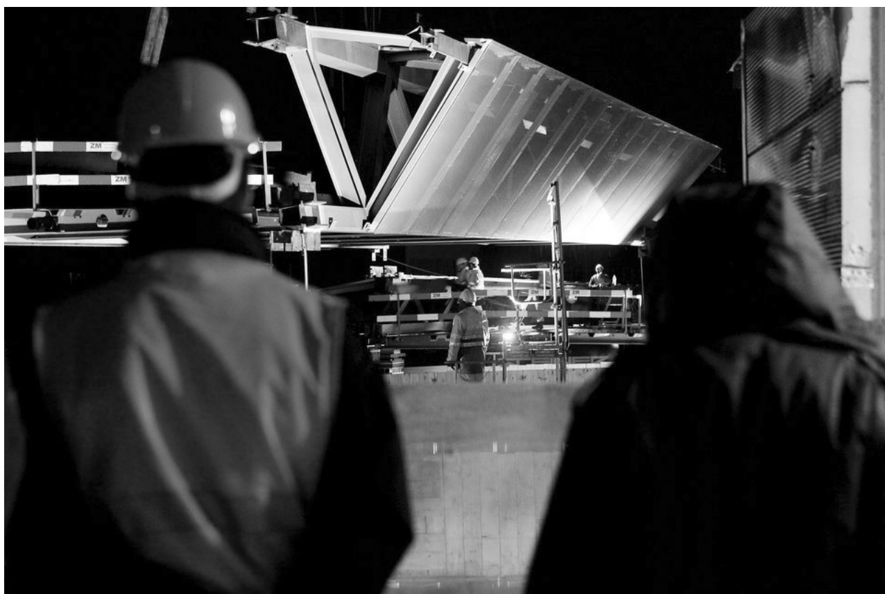
Pose du deuxième tronçon de la passerelle Sécheron-Nation de nuit
