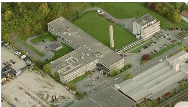
Vue aérienne du site des laboratoires Sauter, chemin de l'Etang, Vernier, 2007 © Bénédicte Frommel et Tanari Architectes.
