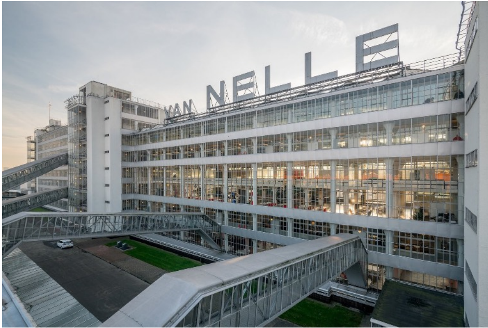
L'usine de tabac Van Nelle à Rotterdam. L'importante transparence des façades laisse apparaître la structure porteuse du bâtiment, des colonnes-champignons en béton armé.
