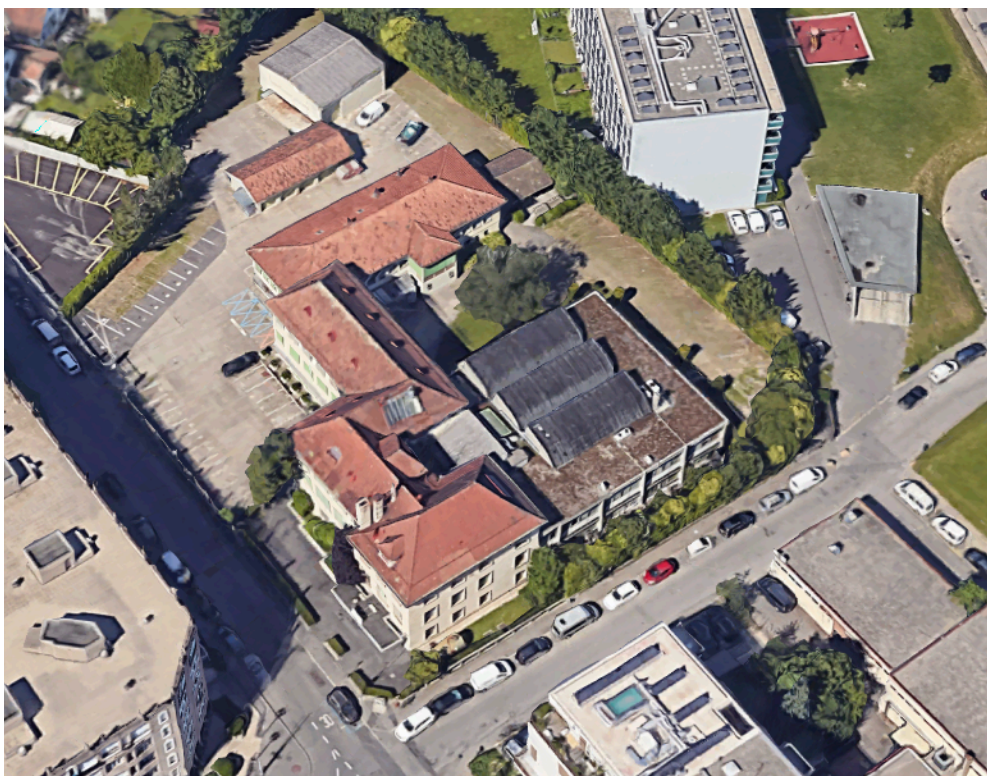
Vue aérienne de l'usine Boninchi dans son état actuel, avec ses volumes articulés © Google Maps
