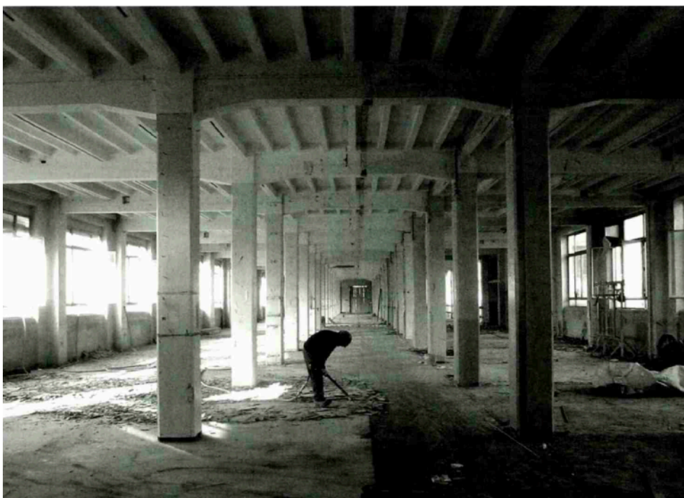
Vues intérieures du bâtiment avant travaux, entièrement vidé © Ris & Chabloz Architectes
