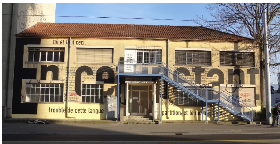
Façade principale de l'ancienne usine Sicli, avec son escalier métallique ajouté récemment. Le bâtiment sert de support à des interventions artistiques, ici une fresque réalisée en 2019 par Karelle Ménine et Iona Suzuki. 2019 © Delphine Luchetta
