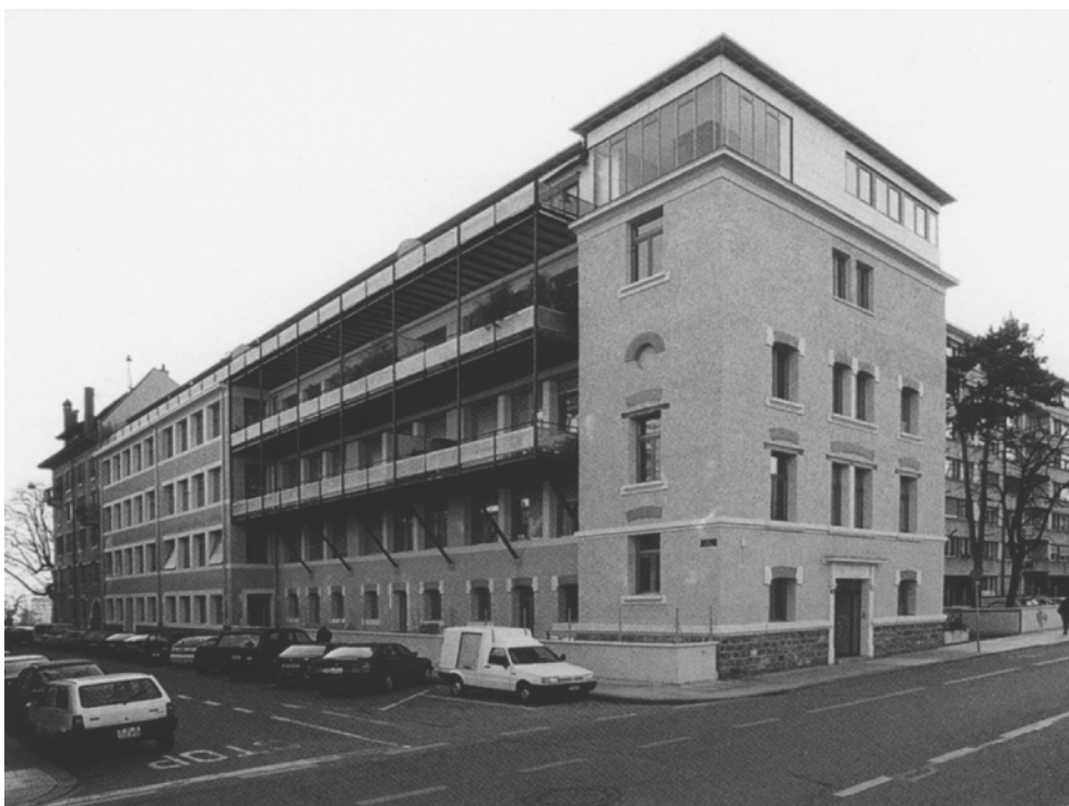
L'immeuble Cinégram après sa transformation par Baillif-Loponte et Associés, 2000 © BLSA Architectes, Genève
