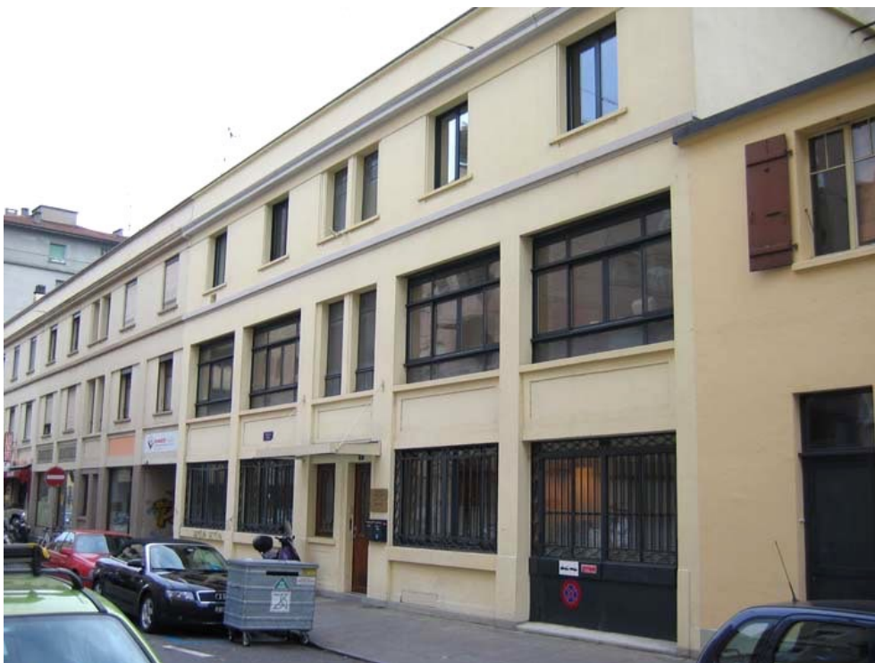
Façade principale de l'ancienne fabrique de bonneterie Oumansky, actuellement occupée par Dianalabs, rue de la Colline, 2006.
