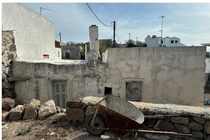
Maison à Tripiti - Façade nord
