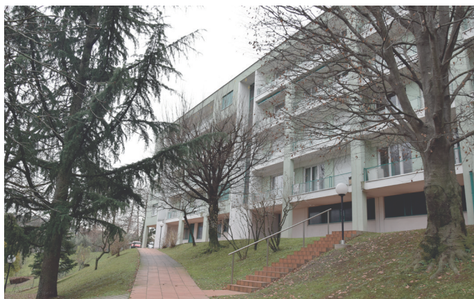
Fig. 74-75 Photos des façades est et west
