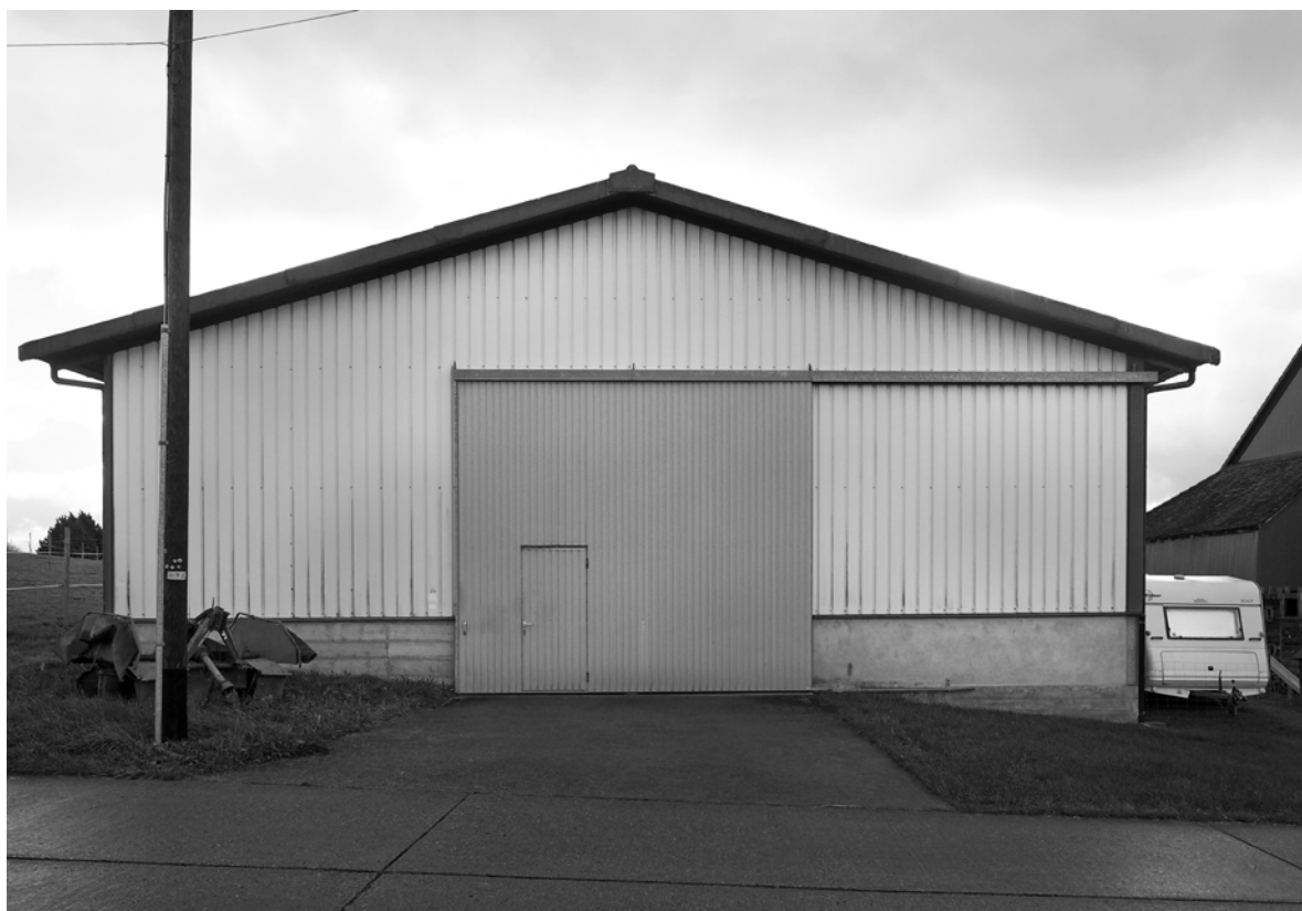
Façade ouest du hangar. 2023
