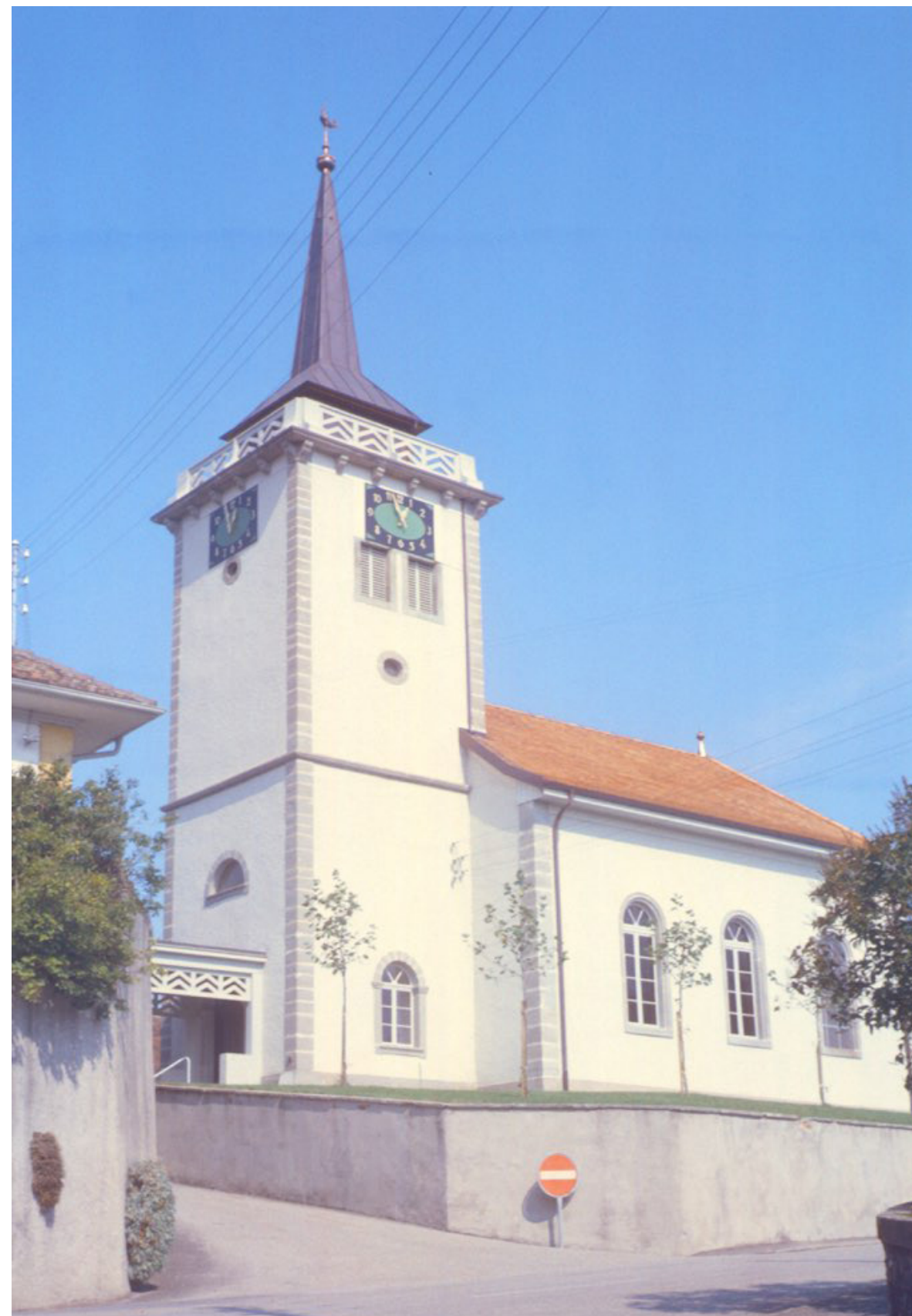
Fig.5. Église du village de Cronay. Septembre 1986. Auteur inconnu.
