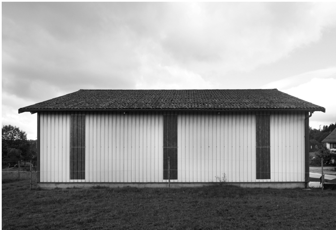
Façade nord du hangar. 2023
