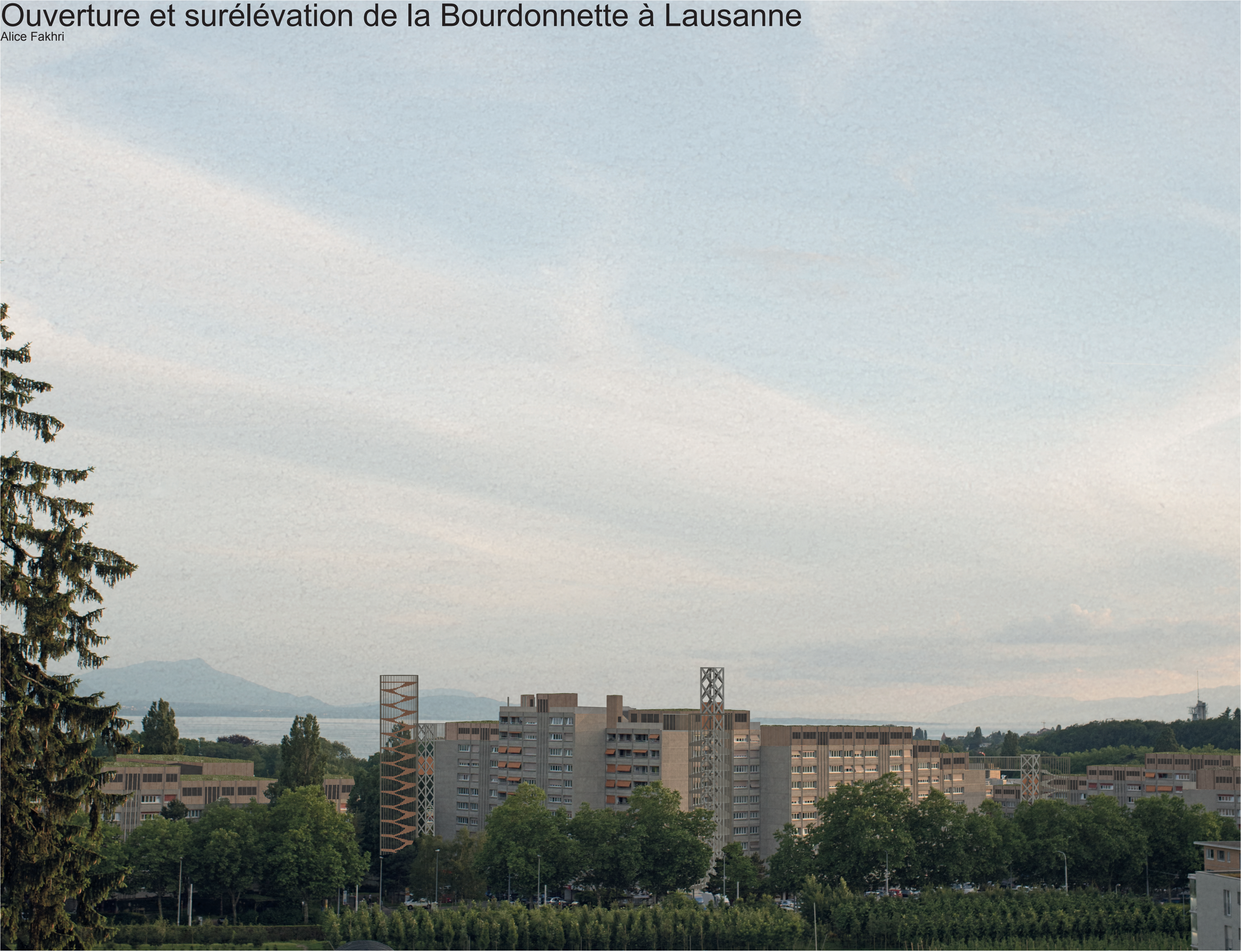
Le corp central de la Bourdonnette avec ses tours permettant l'accès à la promenade sur le toit
