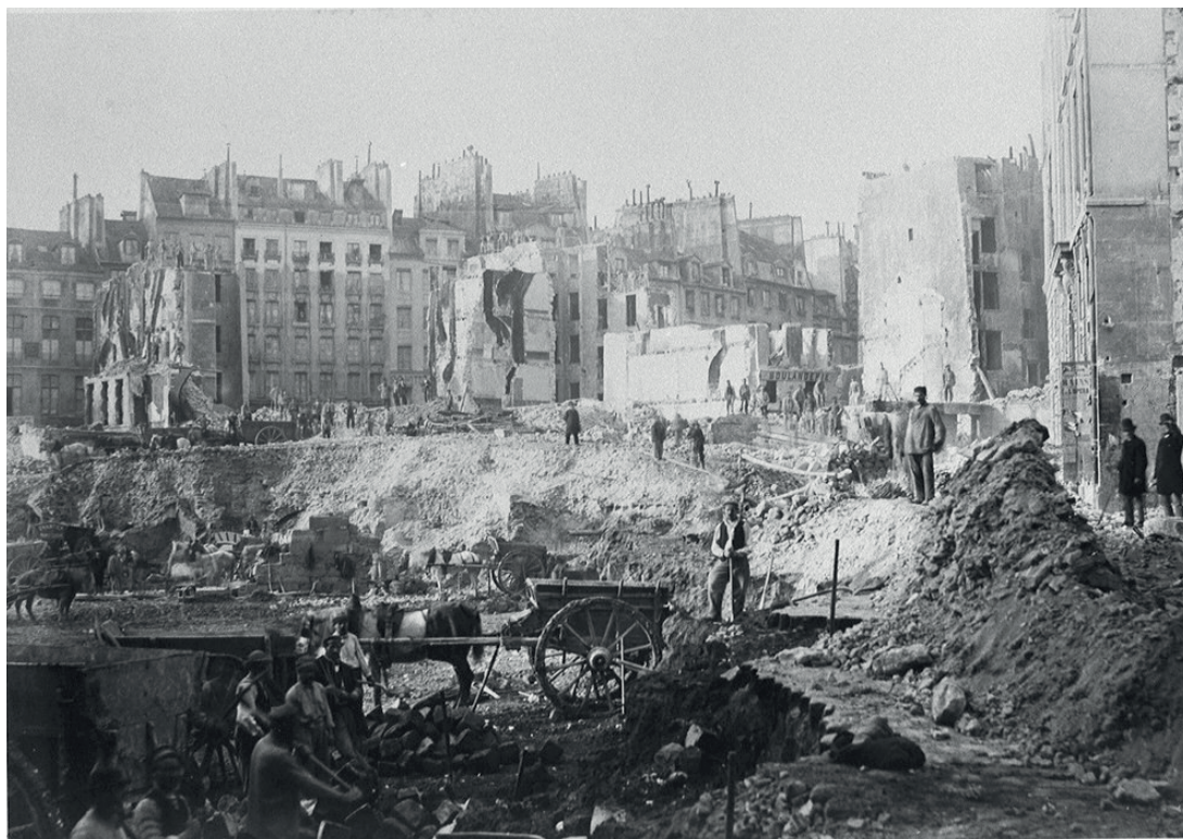
Avenue de l'Opéra. Chantier de la butte du Moulin et de la rue Saint-Roch France, Paris, 1862 Charles MARVILLE
