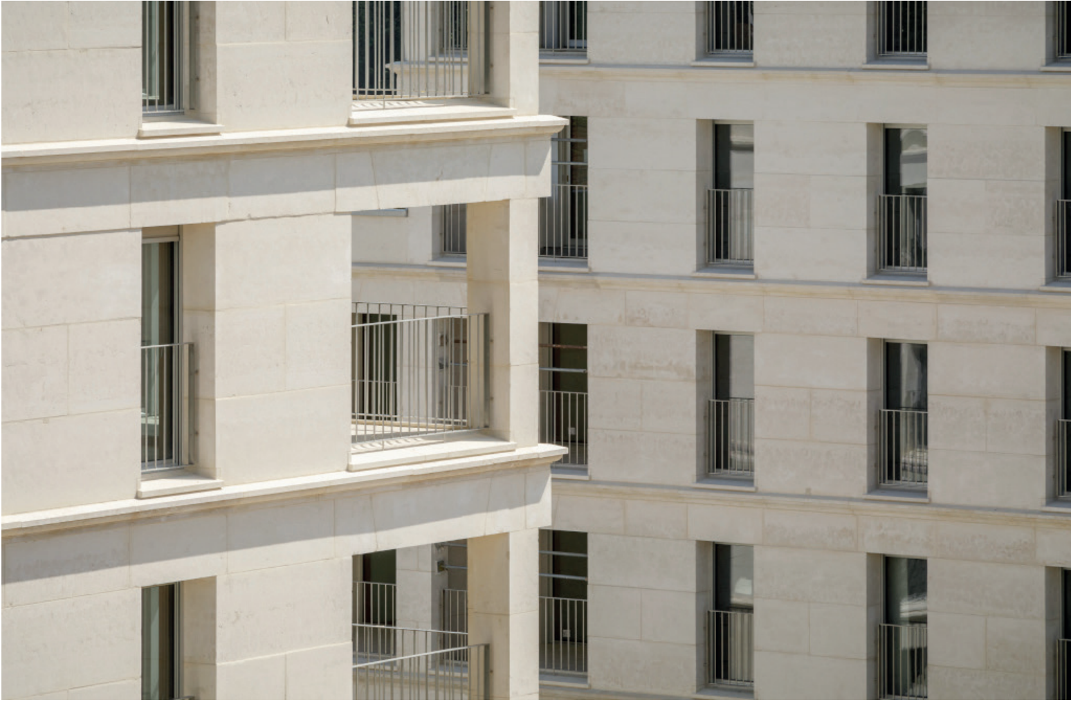
Immeubles en pierre, Perraudin & Archiplein, 2021, Plan-les-Quates
