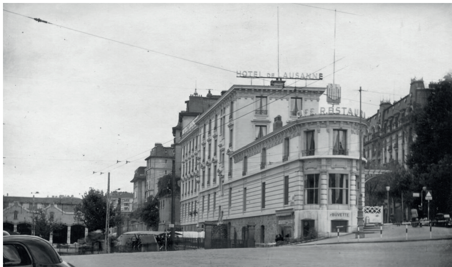
L' Hôtel de Lausanne, construit en 1904, est situé à deux pas de la Gare CFF. Il comptait à l'époque une cinquantaine de chambres
