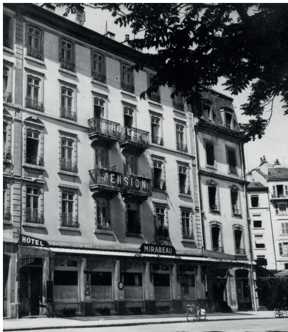
L'Hôtel Mirabeau, Genève. Les constructions mi- toyennes ont été démolies et remplacées par la suite
