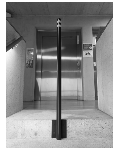
Pour éviter le risque de chute
