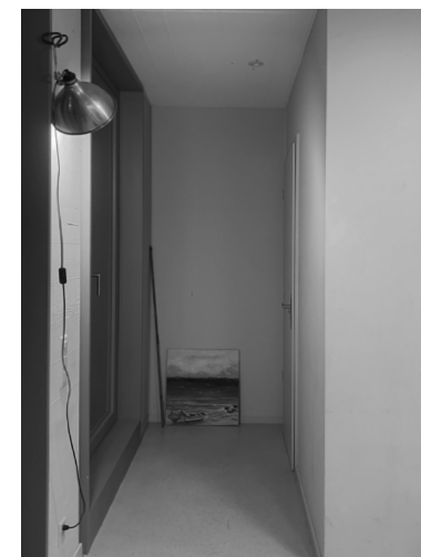
Seuil pour accéder à la terrasse commune de 20cm inadapté
