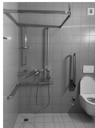
Barres d'appui
