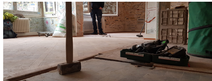
Fig.1 les travaux à Simplon, Photo: Julien Ineichen,
