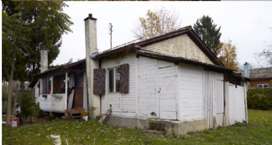
Ancien baraquement ouvrier de l'après-guerre, ALJF, Chemin du Bois-Gentil 30, Lausanne.
