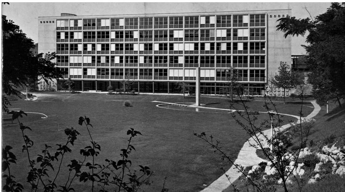
Fig. 64. - Façade est du bâtiment de l'École complémentaire professionnelle et de l'École Romande de Typographie, photographie de M.F. Martin, 1950 (image dans la plaquette de l'Ecole)
