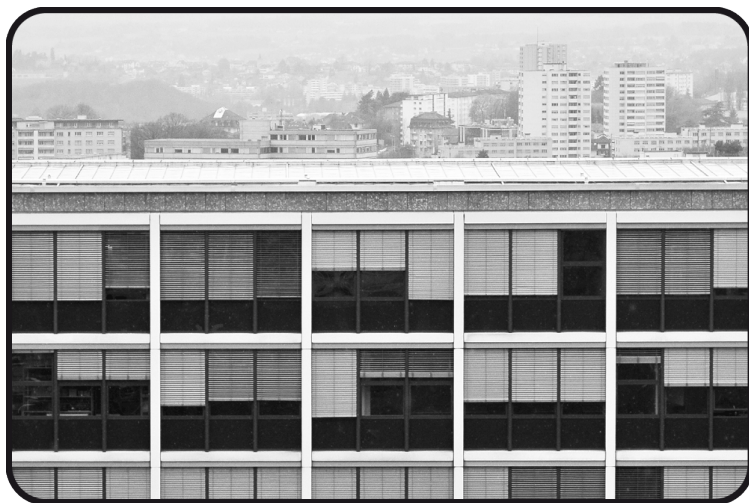
Fig. 68. - Un écran depuis le Pont Chauderon, photographie ©Randonature Sàrl, date n.d
