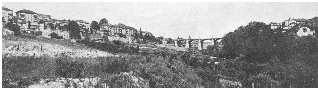
Fig. 55 - En aval du pont Chauderon, 1925
