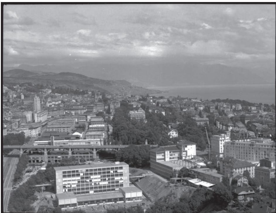
Fig. 62. - L'Ecole professionnelle vue depuis l'ouest, photographie Albert Würigler, vers 1955-1960
