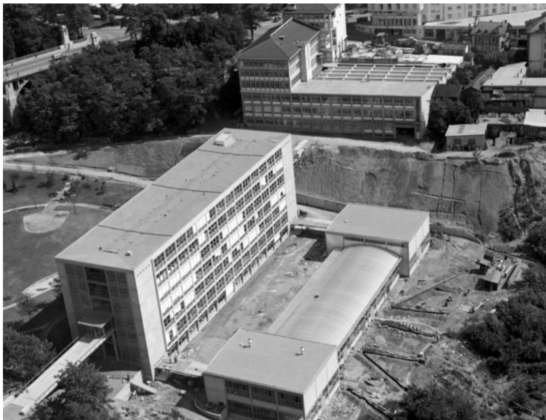
Fig. 70. - Bâtiment de l'Ecole professionnelle, photographie Albert Würigler, vers 1955-1960
