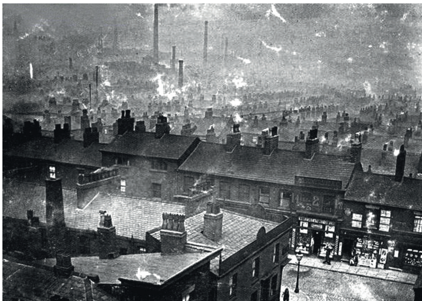
6 Ancoats, Manchester, 1870s, Première banlieue industrielle du monde.
