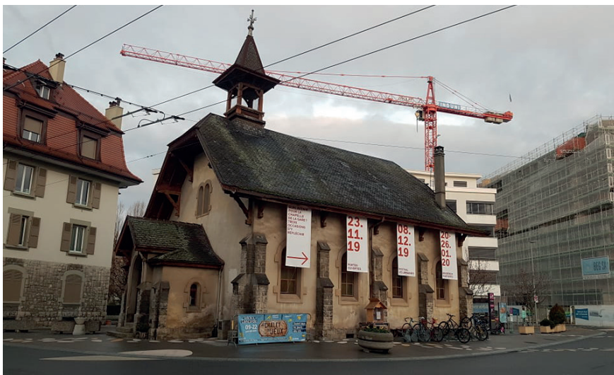
18 Chapelle de la gare, Chavannes-près-Renens, décembre 2019, requalification du bâti de 1901
