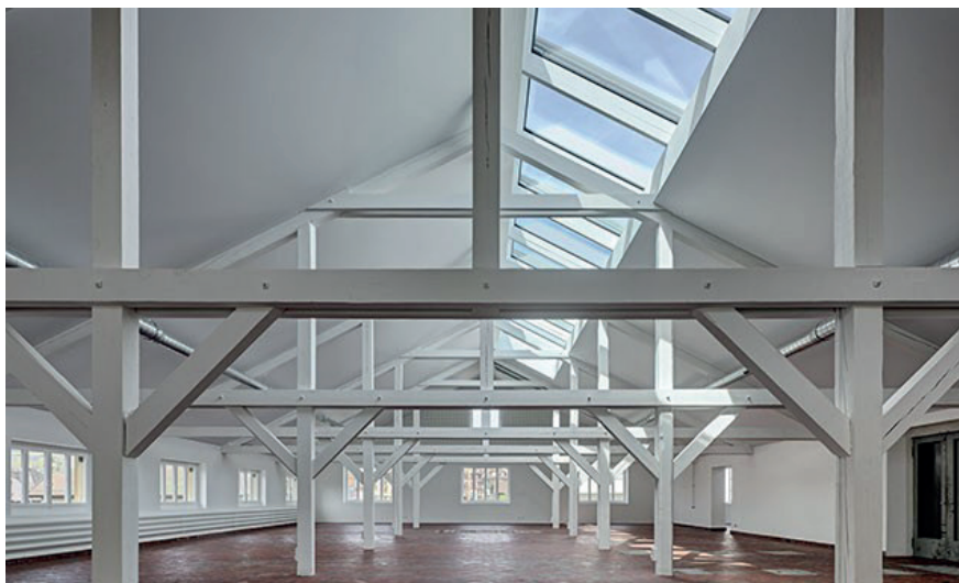
19 Pont 12, bureau d'architectes. Chavannes-près-Renens, 2014, Ancienne fabrique de chocolat. réemploi.
