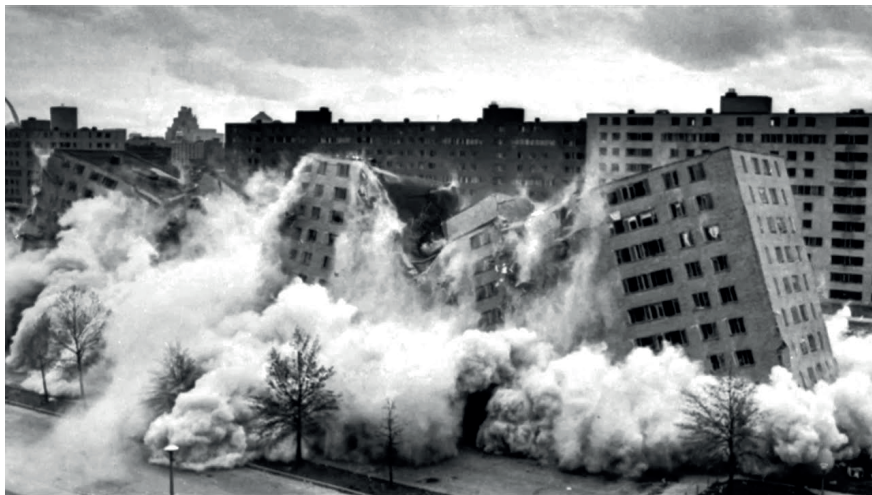
20 Démolition du complexe architectural Pruitt Igoe, Saint Louis, 1972
