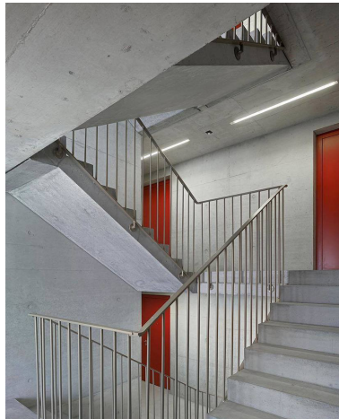
Fig.54 «Cage escaliers intérieurs»
