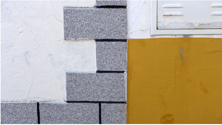
Fig.66 «Détail d'une façade»
