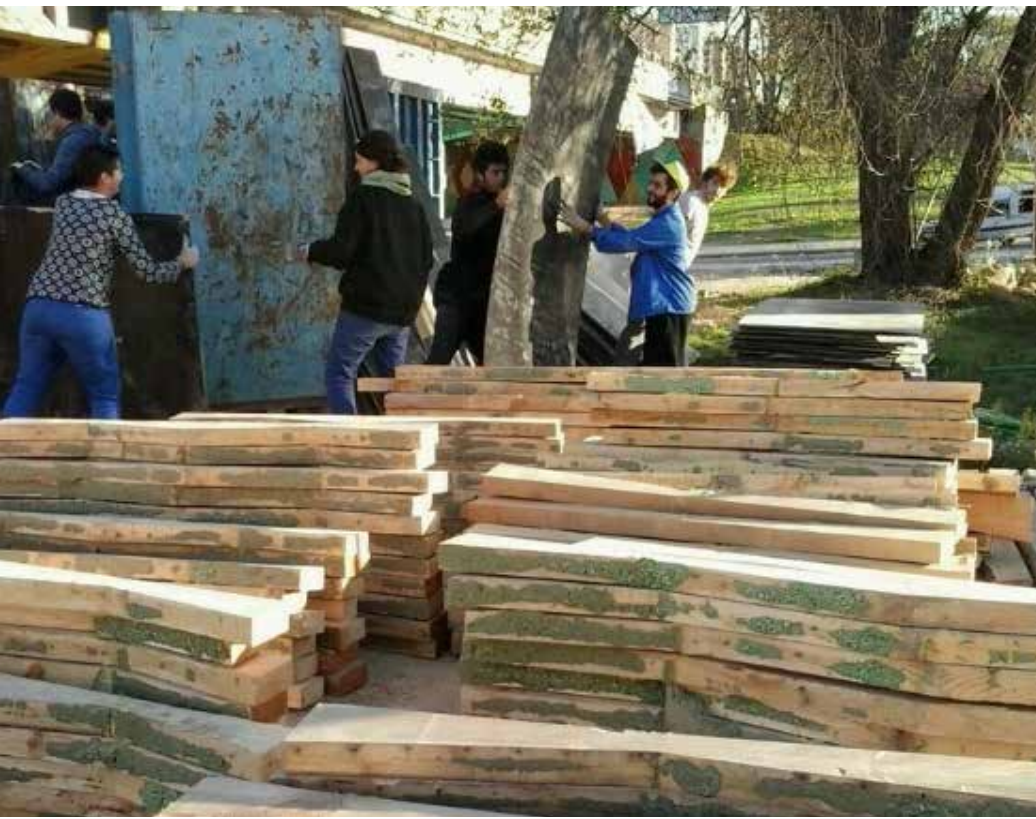
Chantier en cours - organisation et livraison.
