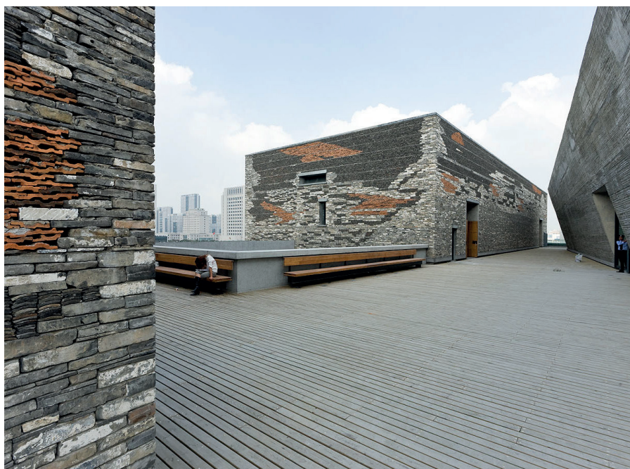
En haut: façade du musée maritime Kaap Skil, en bois de réemploi, réalisé par Mecanoo Architecten. © Christian Richters En bas: façade du musée d'Histoire de Ningbo, en briques de réemploi, réalisé par Wang Shu. © Iwan Baan
