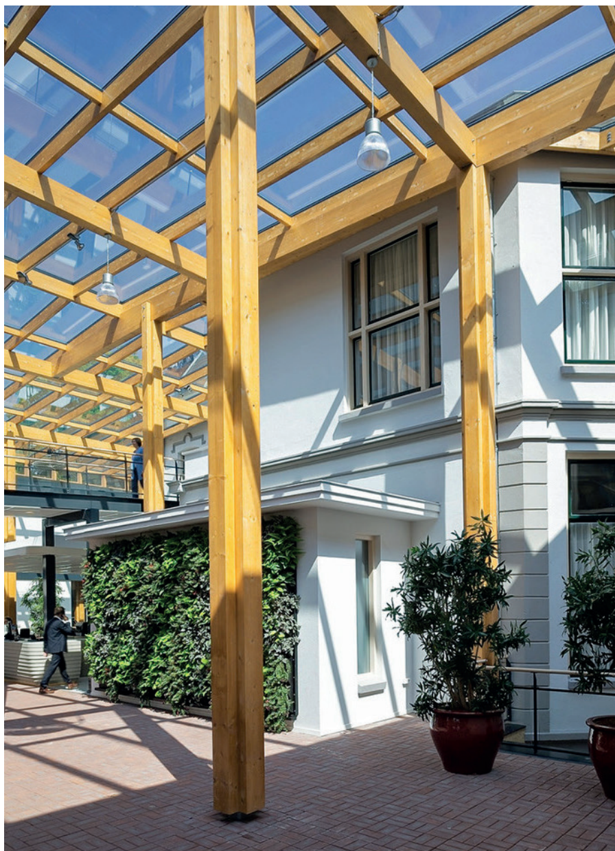
L'extension de l'hôtel de ville de Brummen, réalisée par le bureau d'architectes RAU. © Petra Appelhof
