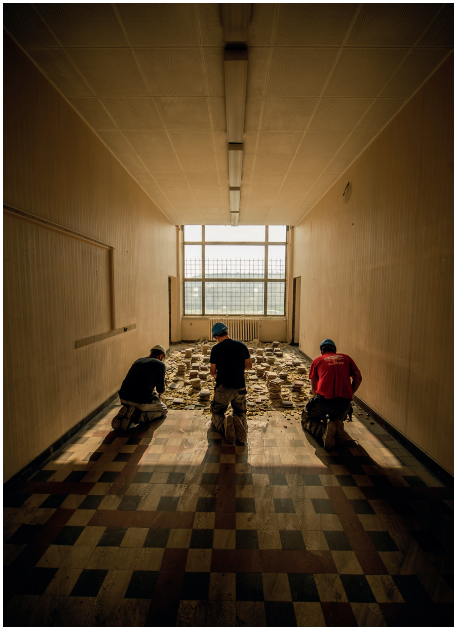
Les nouveaux métiers du réemploi, qui consistent ici à démonter méticuleusement des carreaux. © Rotor
