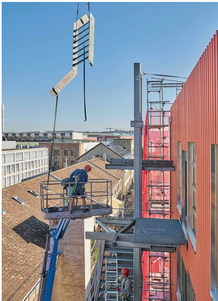
Acheminement et montage de l'escalier extérieur. © Martin Zeller
