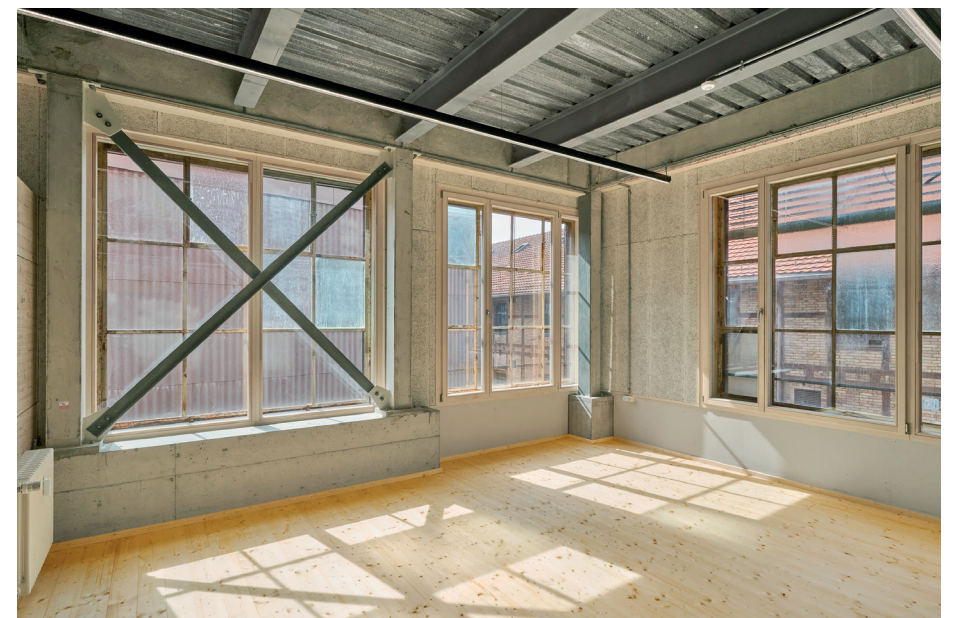
Fig.80 Bureau au 1er étage
