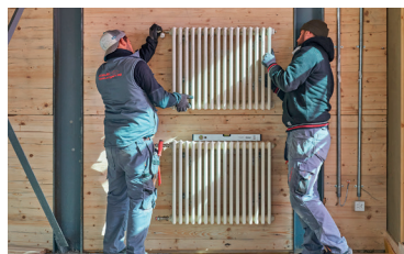
Fig.78 Réseaux électriques et radiateurs apparents
