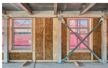
Fig.73 La paille en attente de l'enduit en terre
