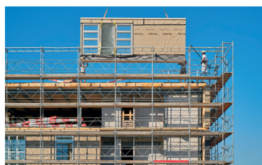
Fig.72 Pose des éléments de façade préfabriqués sur le chantier
