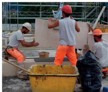
Fig.41 Pose des pierres lors du chantier
