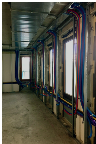
Fig.45 Pré-installation des tubes électriques dans le doublage intérieur
