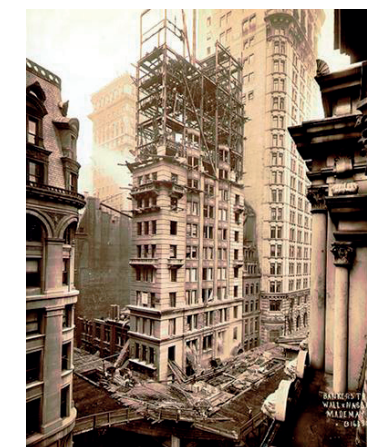
Fig.21 Démolition du Gellender Building
