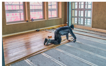
Fig.76 Pose du parquet
