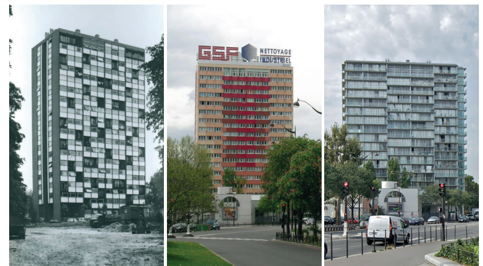
Fig.34 Transformation successive de la Tour Bois le Prêtre à Paris (Raymond Lopez 1959, Rénovation 1990, transformation Lacaton & Vassal 2011). Le bâtiment a su s'adapter pour survivre.
