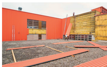
Fig.70 Déconstruction sélective des panneaux de façade
