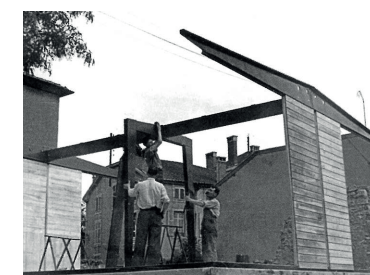
Fig.8 Construction d'une maison à portiques
