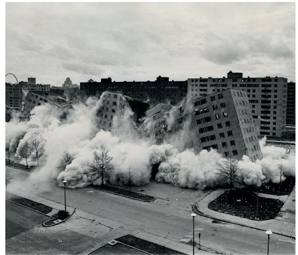
Fig.5 D  molition destructive de l'ensemble Pruitt-Igoe    Saint-Louis (US) en 1972
