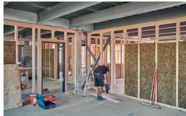
Fig.75 Construction des cloisons intérieures
