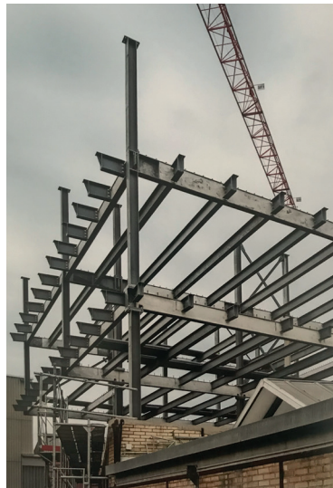
Fig.68 Montage de la structure
