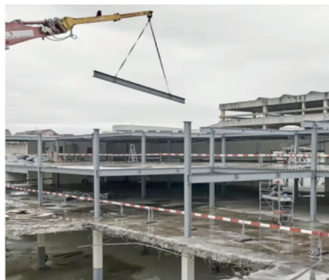
Fig.62 Déconstruction sélective de la structure
