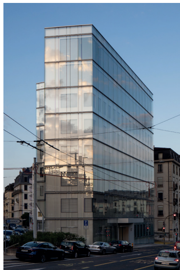
Fig.44 Le bâtiment après rénovation
