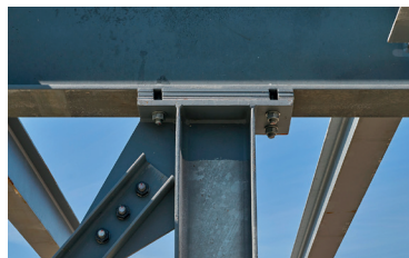
Fig.77 Cales en acier pour aligner les étages à l'escalier
