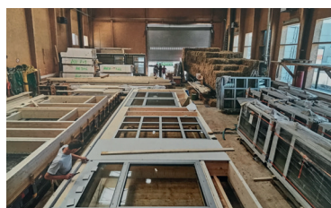
Fig.71 Préfabrication de la structure de façade
