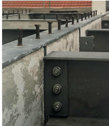
Fig.67 Remplissage en béton des poutres principales
