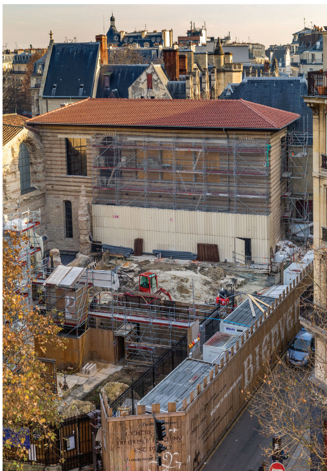
fig.87. 2017, « Retour sur le chantier du nouvel accueil du Musée de Cluny. - OPPIC ».
