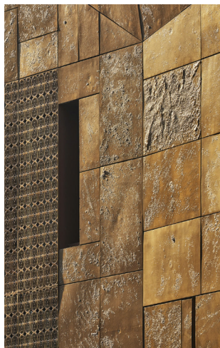
fig.90. Façade Ouest Michel Denance, 2018
