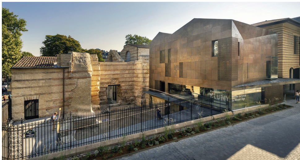
fig.97. Vue sur les vestiges antiques (caldarium L) et la nouvelle extension , Célia Uhalde, 2018
