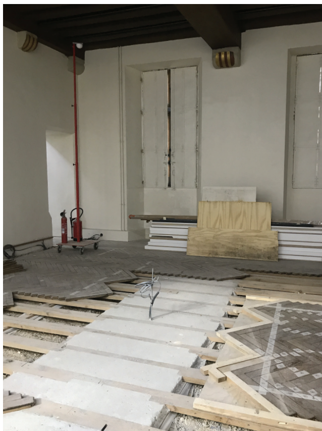
fig.134. Consolidation parquet RDC Hôtel Octobre 2020
