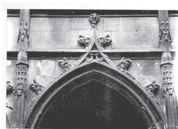
fig.43. Gâble de la galerie ouest dans la cour sud 1931 Denise Jalabert RMN-GP
