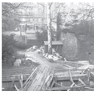
fig.82. Fouilles archéologiques : dégagement des fondations, mur des thermes, 1949, RMN-GP
