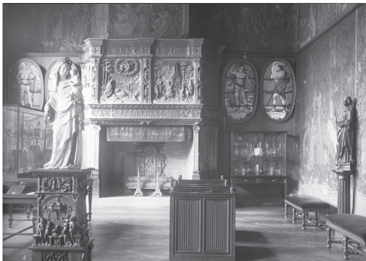
fig.73. Salle du musée dans l'hôtel des abbés, cheminée ajoutée Médiathèque de l'architecture et du patrimoine, diffusion RMN-GP
