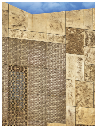
fig.131. Façade Ouest Michel Denance, 2018
