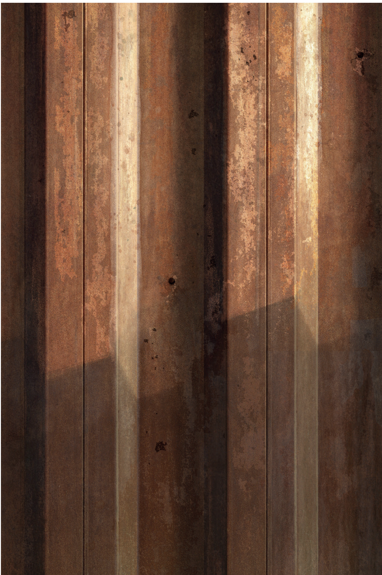
Lumière sur les palplanches déclassées qui constituent le revêtement extérieur 1:10
