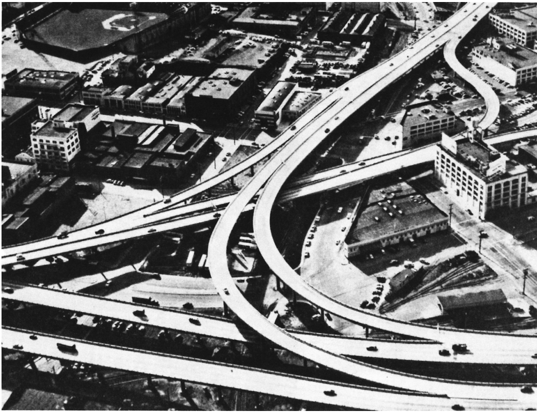
Figure 144 Photo d'un croisement autoroutier à Oakland en Californie, 1963
