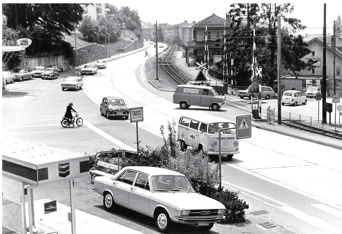
Figure 163 Photo du carrefour entre les routes du Chasseur et de Neuchâtel et du LEB à Prilly, vers 1960 Source : Archives communales de Prilly
