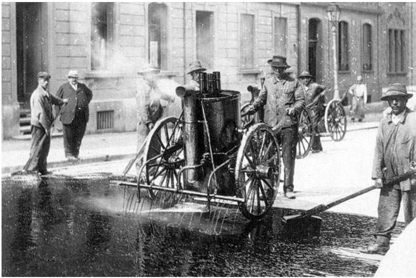
Figure 46 Photo du goudronnage d'une route à Bâle, 1915
