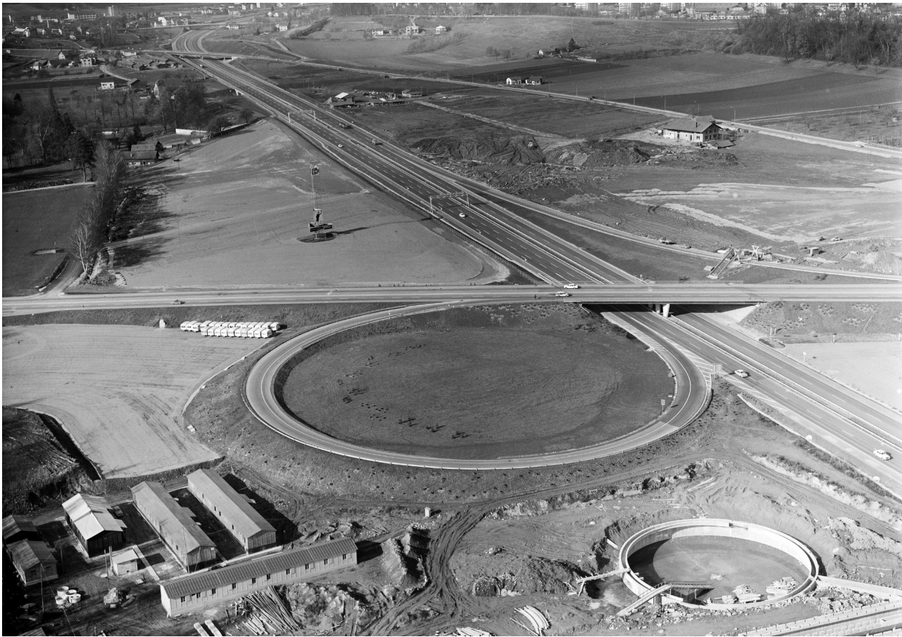
Figure 148 Photo aérienne de l'échangeur 2 Malley-St-Sulpice de l'autoroute A1, 1964 Source : Comet Photo AG, (ETH-Bibliothek Zürich, Bildarchiv, 1964), https://doi.org/10.3932/
