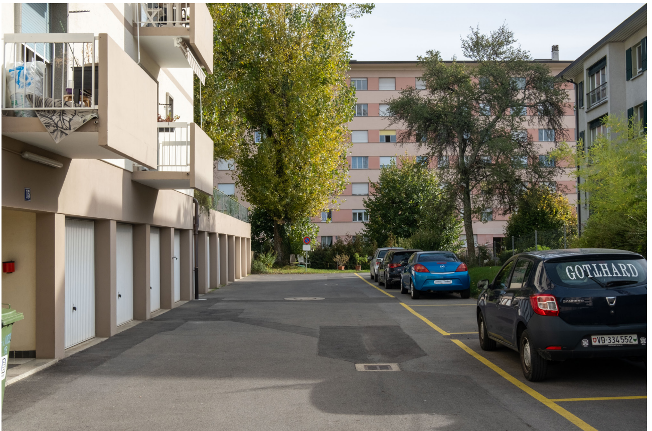
Figure 158 Photo des immeubles à l'avenue de Floréal 13 et 15 et de leur voie de desserte, Prilly, 2023 Source : photos de l'auteur.
