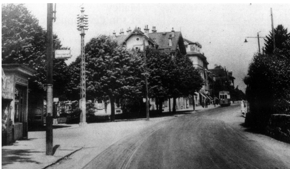
Figure 51 Photo de la route de Cossonay à Prilly, 1935 On constate une distinction entre la route et ses abords. La route dispose probablement d'un nouveau revêtement, dont il est difficile de déterminer s'il s'agit de goudron, d'asphalte ou de macadam. Dès 1914, un rouleau compresseur est utilisé pour les travaux d'entretien de la route de Cossonay. Durant les premières décennies du 20 e siècle, la voie est élargie sur de nombreux tronçons afin d'y flanquer des trottoirs, lorsqu'ils étaient encore absents. Source : Archives communales de Prilly
