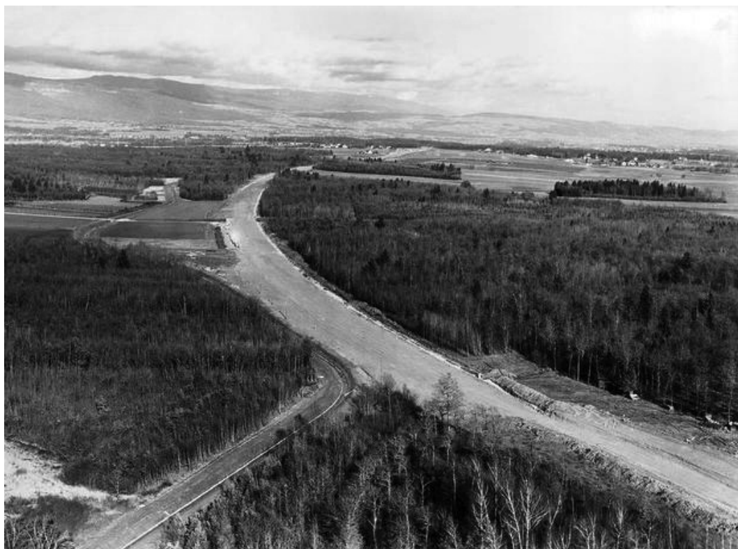
Figure 145 Photo aérienne du chantier de l'autoroute A1 dans la région de la Côte, 1960 Source : Archives cantonales vaudoises.
