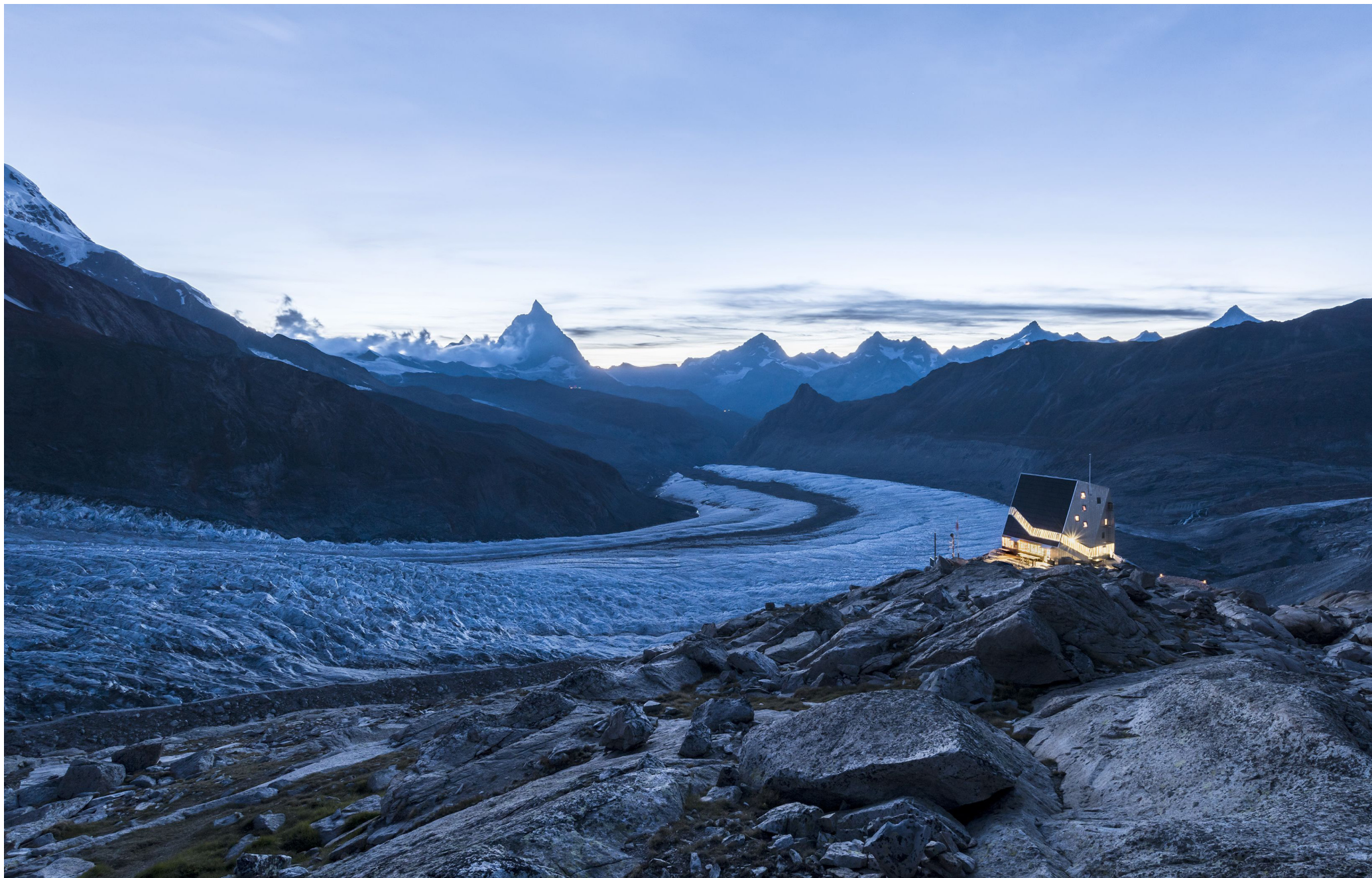
Zermatt, Valais Bearth & Deplazes, Monte Rosa Hütte , 2009. Photo: David Schweizer
