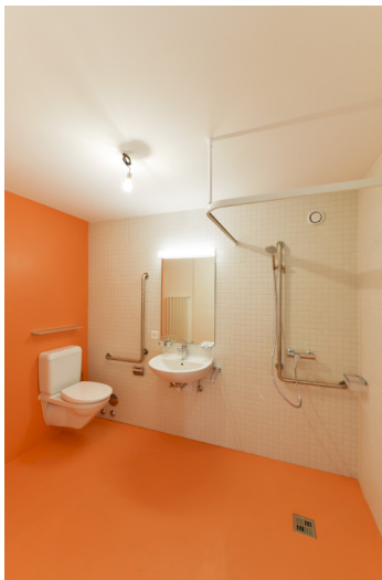
Fig. 1 salle de bain adaptée Source ► Chappuis architectes
