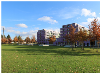
Fig. 6 le park de l'Eulach et la Giesserei
