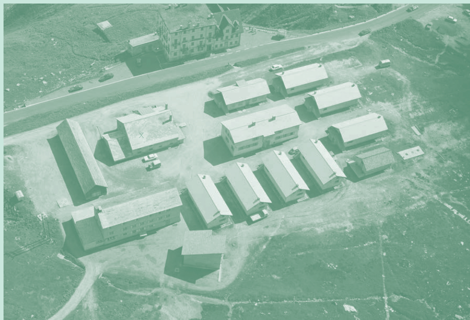
49. camp militaire, 1979. A noter que le bâtiment x a été détruit en 2019
