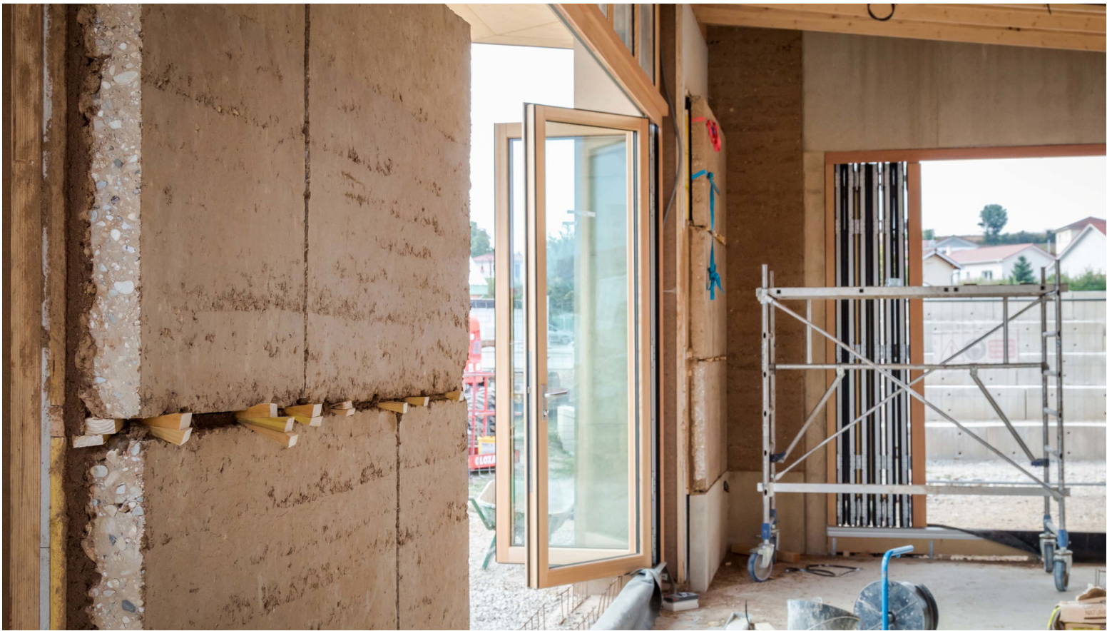
Finition intérieure en pisé, Maison pour tous
