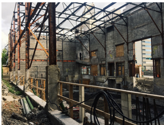
L'ancien cinéma complètement évidé pour sa transformation en logements. Photo: Laurie Charron-Lozeau, 2019.
