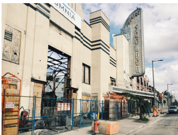
Le chantier en cours. Photo: Laurie Charron- Lozeau, 2019.
