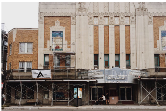
Façade principale de l'ancien cinéma Le Château en réfection. Photo: Laurie Charron-Lozeau, 2019.
