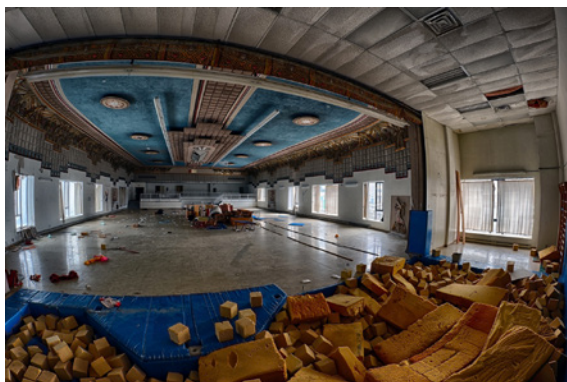
La salle de gymnastique aménagée à l'étage, vacante depuis près de deux ans. Photo: Keven Lavoie, 2015.
