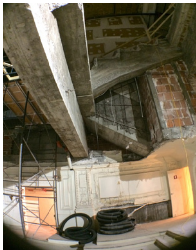
L'intérieur du cinéma Cartier en 2014. Photo: Latéral Ingénieurs.
