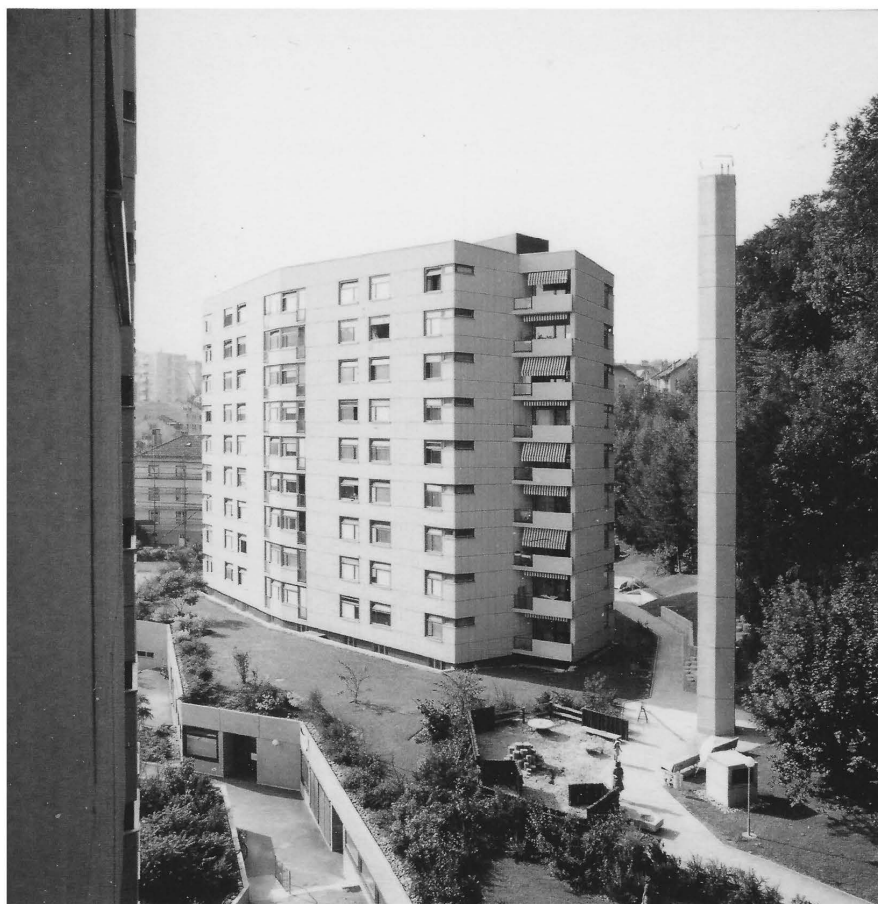
Ci-dessus: Charles et Frédéric Brugger, tours de la Borde, Lausanne, vue aérienne.
