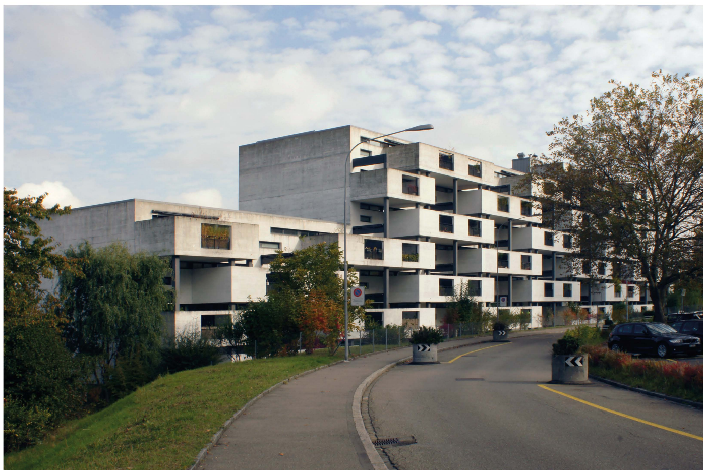
Ci-dessous: Vue de la façade sud-ouest depuis la rue.
