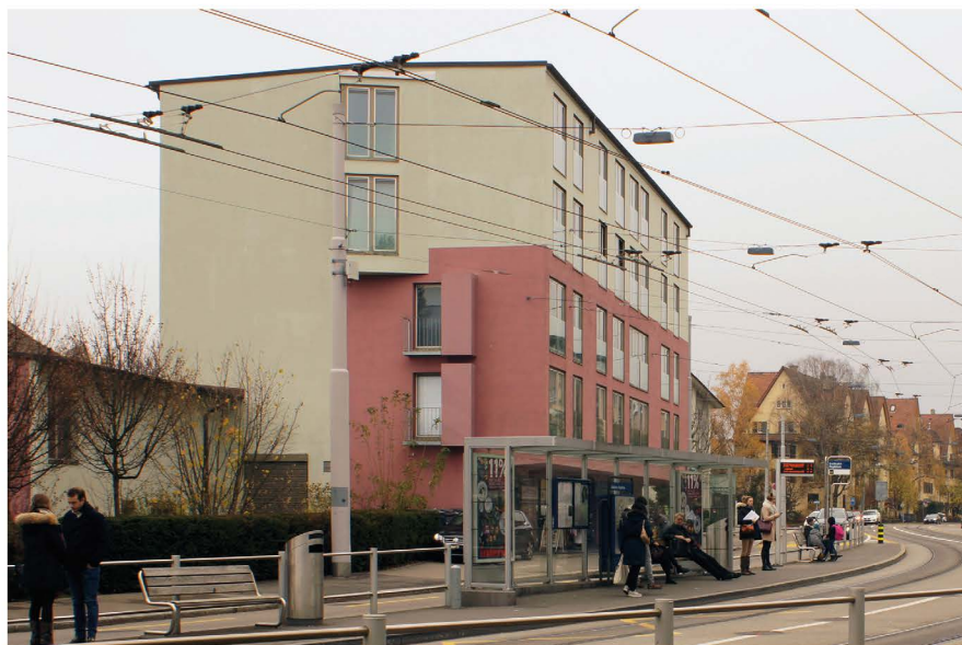
Ci-contre, de haut en bas: Façade ouest du petit immeuble; Façade latérale du petit immeuble.
