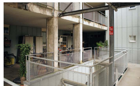
Ci-dessus, de haut en bas: Cage d'escalier; Coursive; Escalier menant aux logements du deuxième étage; Terrasse d'accès collective.
