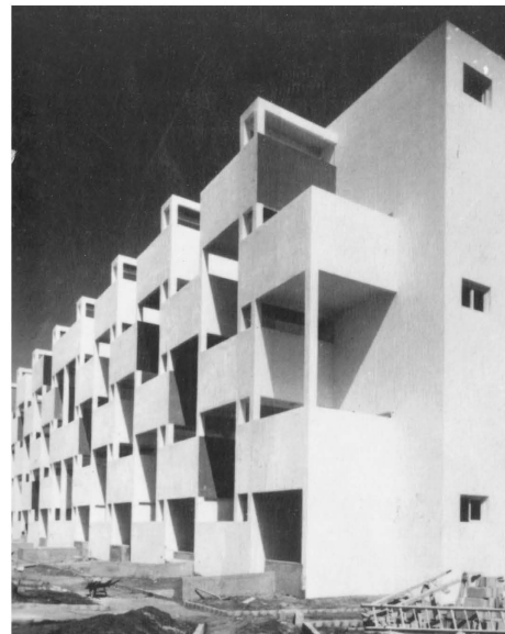
Ci-dessus: ATBAT-Afrique, immeuble type «Nid d'abeilles», Carrières centrales, Casablanca.
