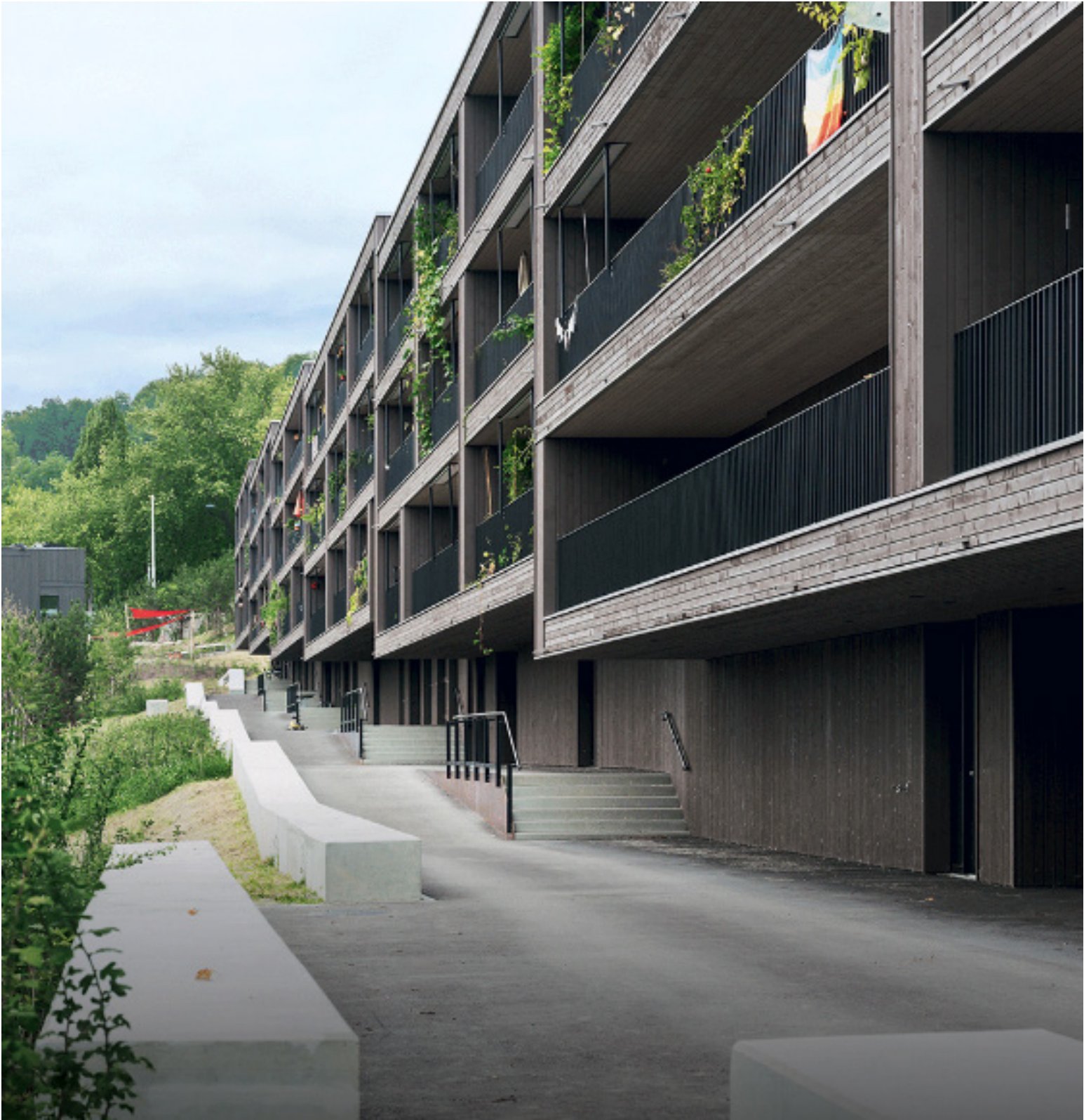
Ensemble d'habitation Tiecherstasse, Büchner Brundler, 2017
