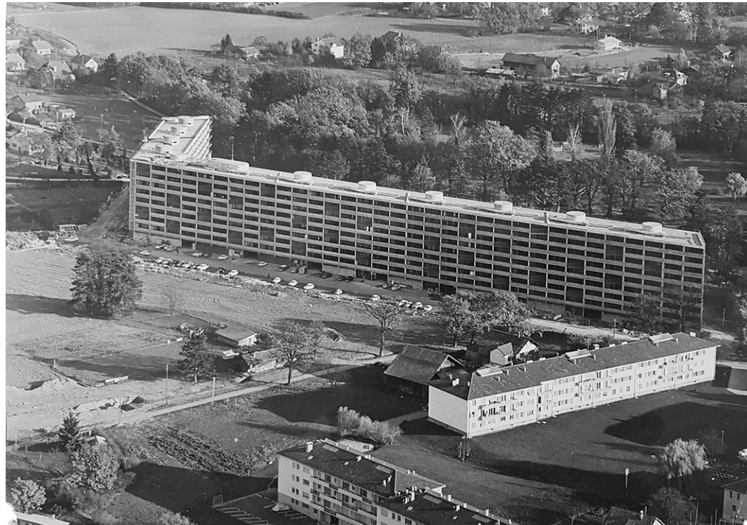
Figure 45 : Vue de la façade nord
