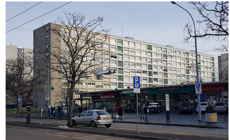
Figure 72 : Vue d'un bloc d'Onex I (Rue de la Calle 19-25) - Rénovation des immeubles de droite, mais pas du pignon à gauche (état en décembre 2021)
