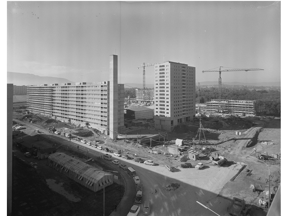
Figure 35 : Chantier de la seconde étape sur la Commune d'Onex
