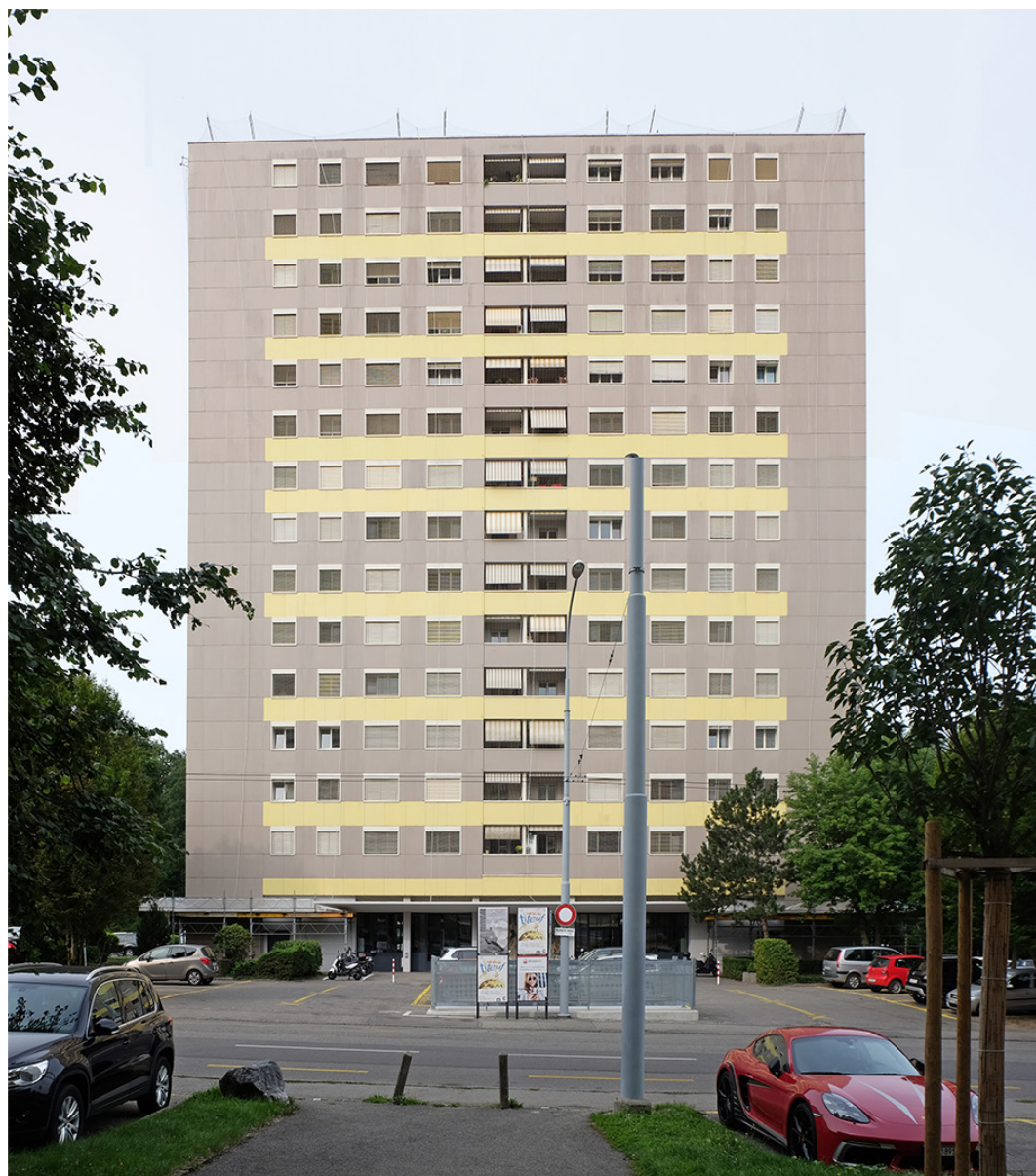
Figure 70 : Vue de la tour (rue du Vieux-Moulin 9-11) après la première rénovation
