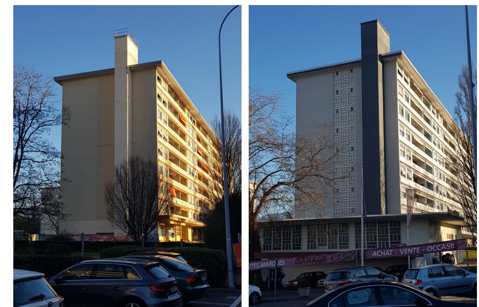
Figure 65 et 66 : Deux des trois cheminées de la Cité-Caroll
