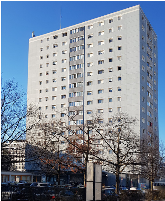
Figure 61 : Vue de la tour après rénovation
