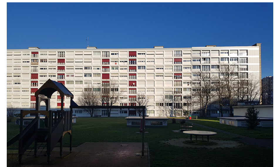
Figure 74 : Vue d'un bloc d'Onex I (Rue du Comte-Géraud 1-7) - Rénovation du pignon à droite, mais pas des immeubles de gauche (état en décembre 2021)
