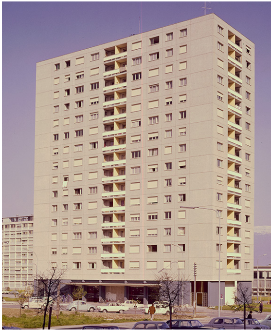
Figure 60 : Vue de la tour à l'état d'origine
