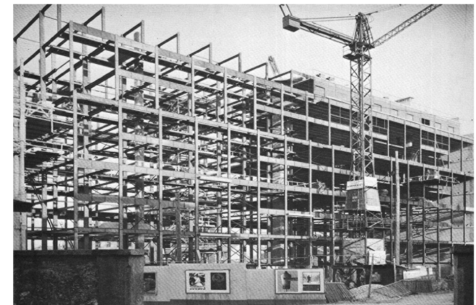
Figure 14 : Chantier de l'Immeuble Clarté
