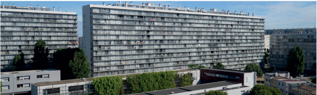
Figure 83 : Etat après rénovation
