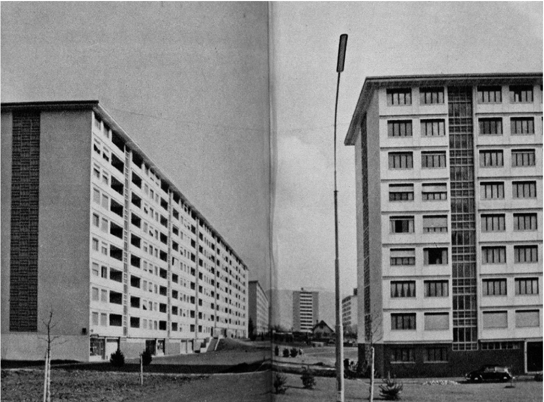
Figure 55 : Vue initiale depuis l'avenue des Grandes-Communes (1965)
