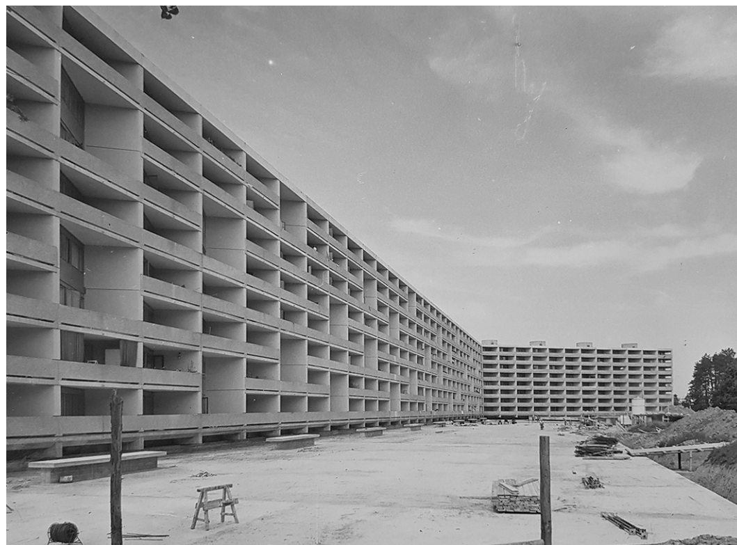
Figure 46 : Vue de la façade nord
