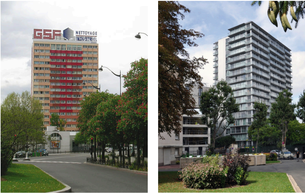
Figure 79 et 80 : État existant et après intervention
