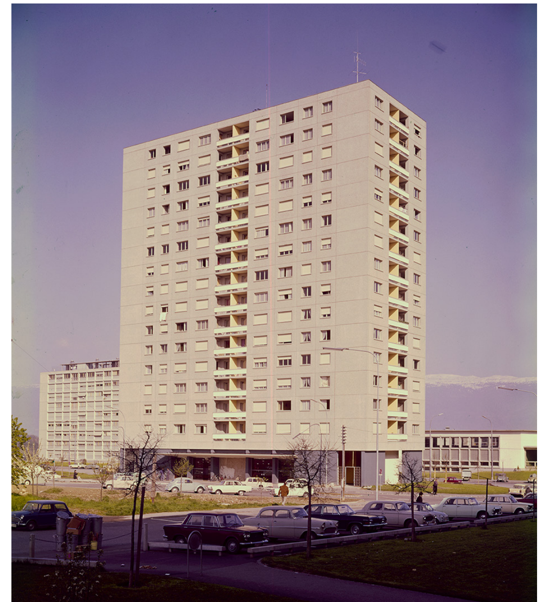
Figure 69 : Vue de l'une des quatre tours à son état d'origine (Avenue de Gros-Chêne 41-43)
