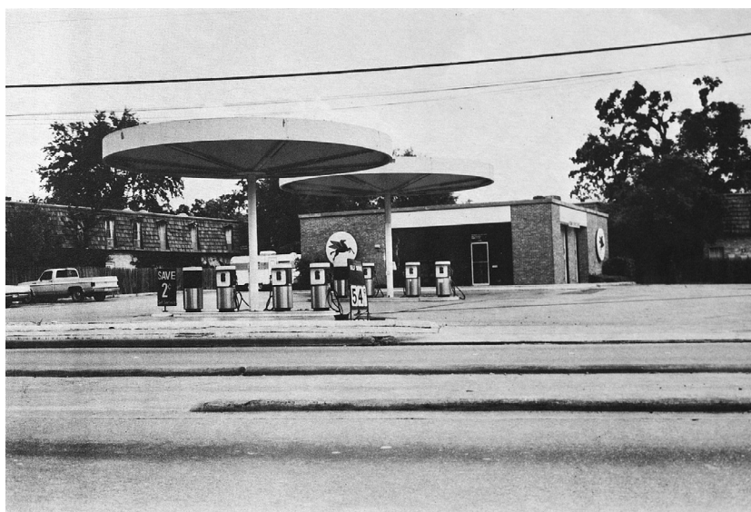
Fig 1.32 Station essence avec le couvert en forme de 'champignon' de Noyes.
