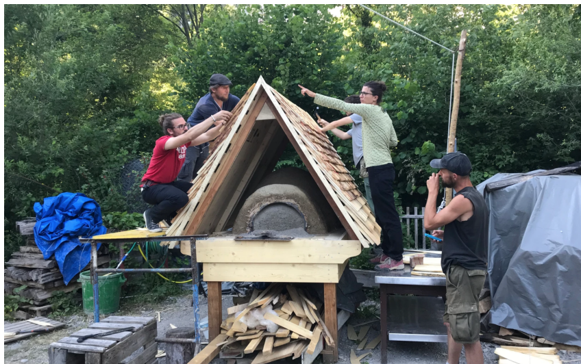
Tavillonnage du four à pain du Port de Fribourg, Association Espace-Temps
