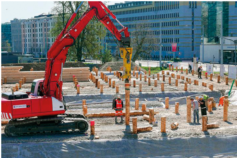
Fig. 66. Pieux de bois pour les fondations de l'Opéra des Nations, Genève, Suisse © Charpente Concept
