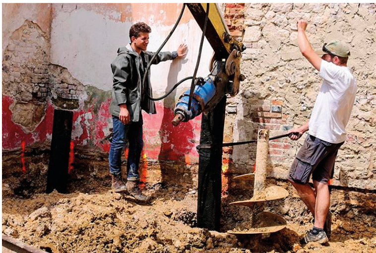
Fig. 67. Pieux de bois brûlés en surface, Sap-en-Auge, France © Anatomies d'architecture / Olivier Sabatier
