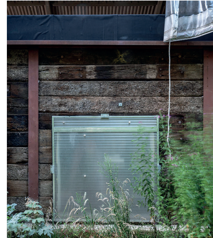
Clancy Moore Architects, Atcost Barn, Castle Cary, 2020 © Sue Barr Réhabilitation d'une ancienne grange, processus ad-hoc utilisant seulement les matériaux qui se trouvent à portée de main
