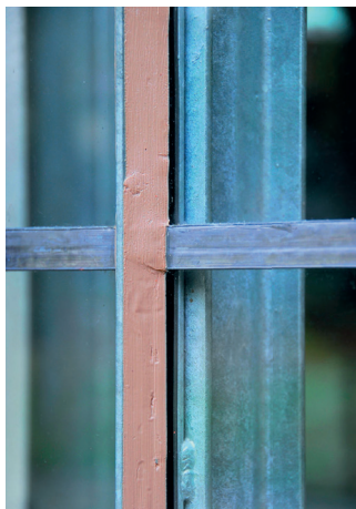
Bakker et Blanc, Orangerie du château de Romont, Romont, 2007 © BABL Détail de la façade en plomb, verre étiré et mastique de l'orangerie du château de Romont.
