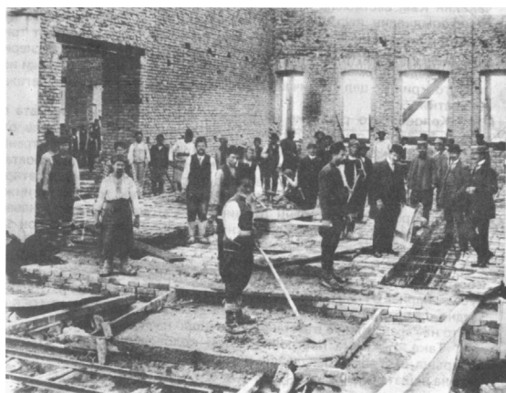
(fig. 58) la gare actuelle en construction
