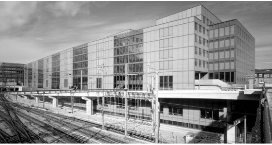
(fig. 13) Peter Merian Haus à Bâle - un klumpen pour la HES nord-ouest
