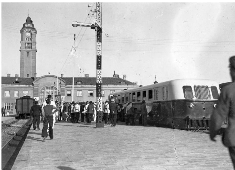
(fig. 28) à la gare de Varna vers les années 1940
