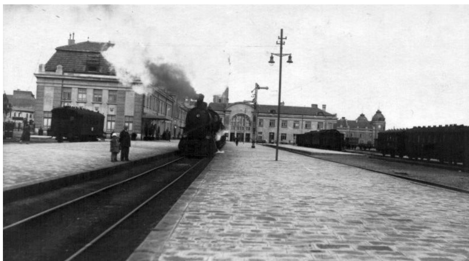
(fig. 53) la gare de Varna vue depuis les quais
