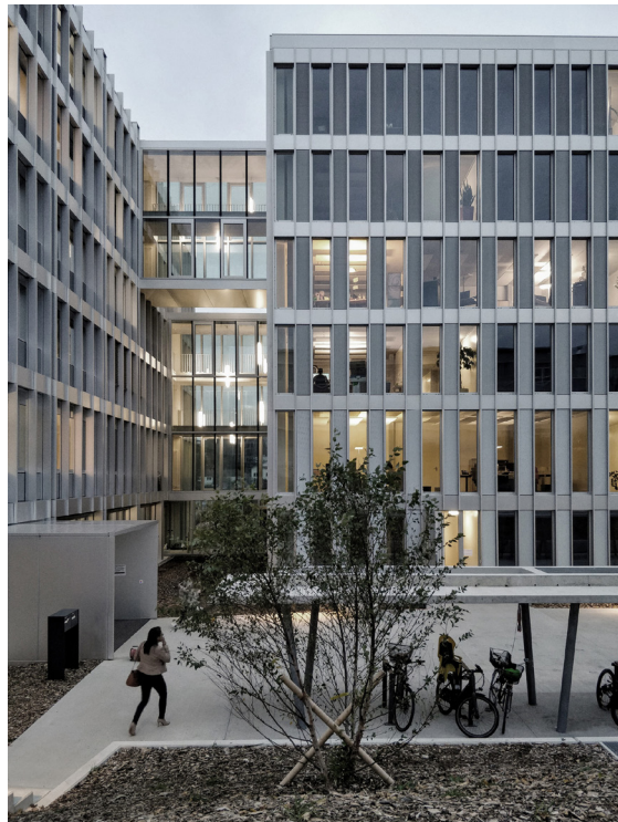
Figure 29_ aménagements extérieurs de l'ECAS ©Francesco Ragusa
