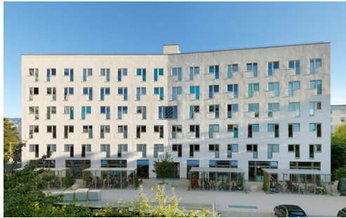
Figure 31_Façade Nord du bâtiment, ©atba architectes.
