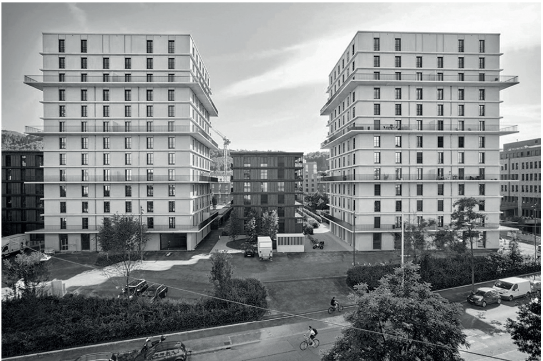
Fig.66- Projet de Rolf Mühlethaler, les tours Rauti à Freilagerstrasse 55 / 61 / 67, Zürich- Suisse.
