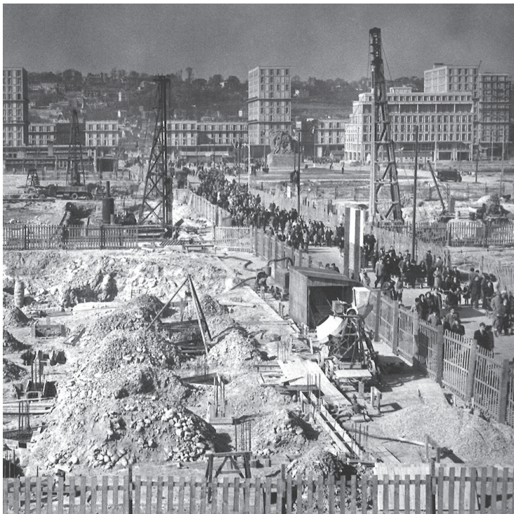
Fig.155 -Chantier du Havre-Rue de Paris-1945 Auguste Perret
