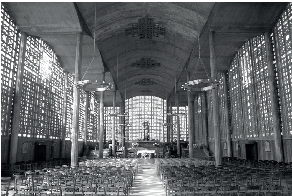
Fig.43-Notre-Dame au Raincy - Auguste Perret, vue vers le nef central Les voûtes qui constituent l'hangar religieux se posent sur les minces colonnes galbées en béton brut de décoffrage. En même temps Perret ajoute un autre rangée prêt des façades en claustra pour distinguer et définir l'abri souverain.
