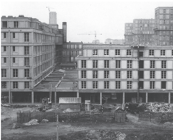
Fig.103- Chantier de l'îlot V35. Place de Chailou. Sur la droite l'alignement des tours ISAI.
