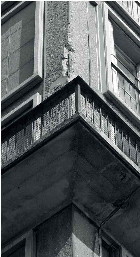
Fig.158- ISAI devant la place Auguste Perret, Le Havre LE BÉTON ARMÉ EST-IL ÉNCORE ADAPTÉ POUR LA QUESTION DE LA CONSTRUCTION DURABLE ?
