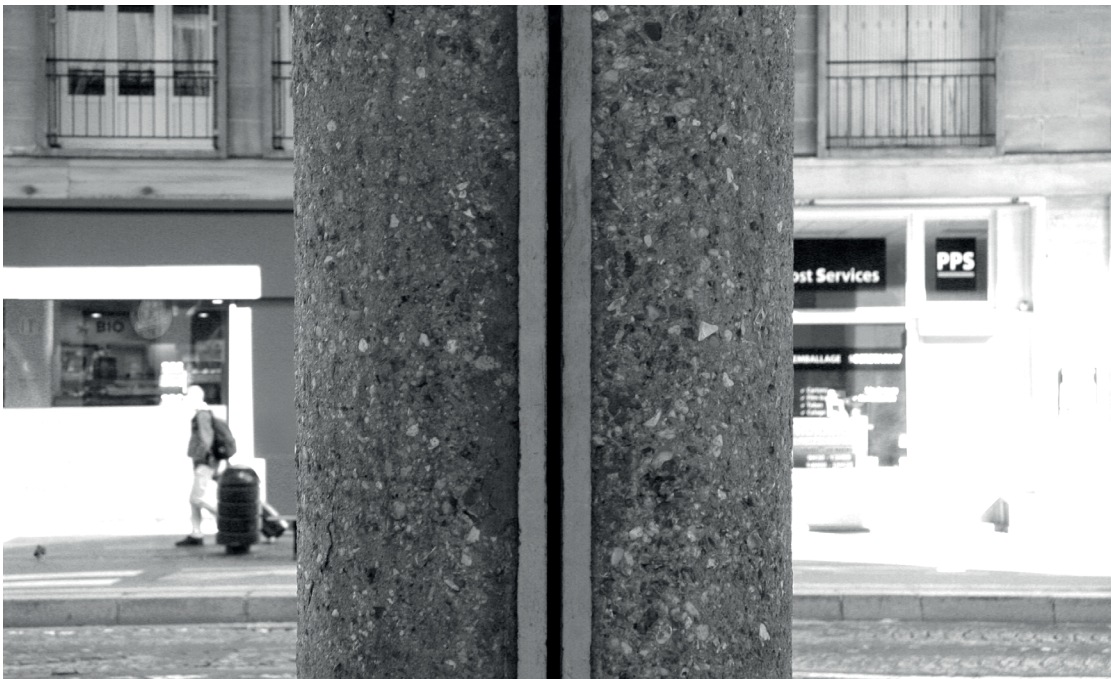
Fig.107 - Joint de dilatation dans une colonne du portique du Rez d'un immeuble ISAI dans la rue de Paris-Le Havre. Le béton bouchardé et le béton lisse dans le dialogue du fin d'une colonne et le début de l'autre.
