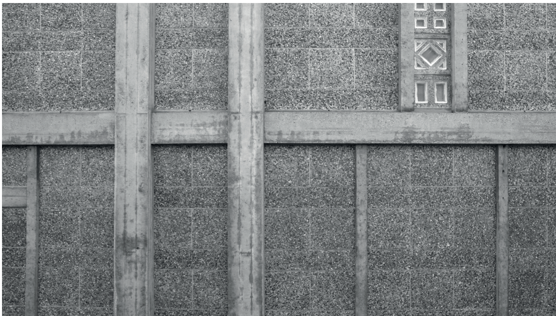
Fig.62- Façade de l'église de St-Joseph - Le Havre, 2019 Au gratte-ciel du Havre on trouve tout, béton brut de décoffrage, béton bouchardé, béton lisse pour encadrer des vitres de décorations. Façade conçue qu'avec du béton, mais on a l'impression que Perret nous a offert une multitude des matériaux avec leur propres identité et expression.
