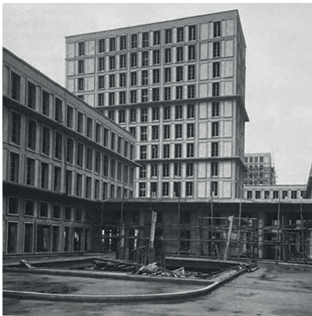
Fig.57- Chantier ISAI 1945 - Atelier Perret- Le Havre Toute la pensée perretienne et aussi son architecture peut la comprendre mieux à travers les chantiers dans leur état de non-finito. Chaque échafaudage, chaque pièce en béton nous racontent des histoires de la construction.
