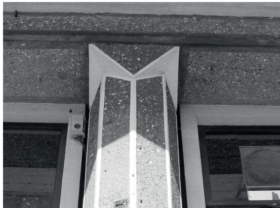
Fig.24-27- Dans le portique du rez des immeubles ISAI et surtout dans la façade de l'Hôtel de Ville le palmier prend des configurations différentes mais elle reste fidele aux mêmes principes et à la même logique constructive. Tout en béton bouchardé.
