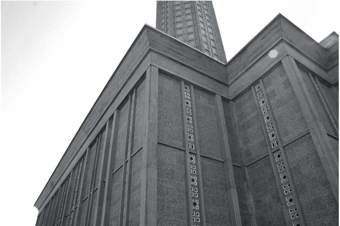
Fig.139-Église de Saint-Joseph, Le Havre 2019 Image qui montre tout. Divinité de la construction. Éssor de la charpente en béton armé et du brutalisme issu du jeu des coffrages. Caractère spirituelle du béton armé. Dualisme entre squelette et le remplissage. Traitement délicat du béton armé avec tout ses éléments composants. Grannulométrie parlante dans une rélation intime avec la lumière.
