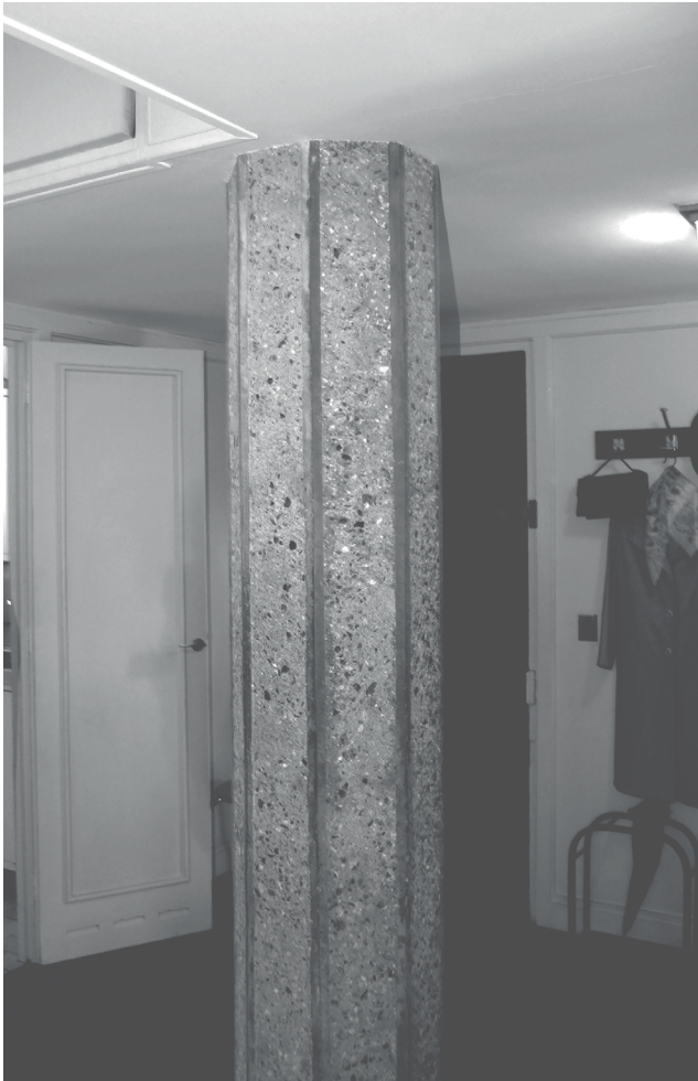
Fig.117-Plan de l'appartement témoin - Le Havre. La colonne octogonale juste en face de la porte se présente comme l'intersection des lignes de trame.
