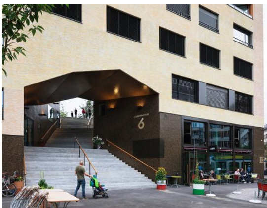
MUELLER SIGRIST ARCHITEKTEN, Kalkbreite , Zürich, 2012-2014 (fig.12)
