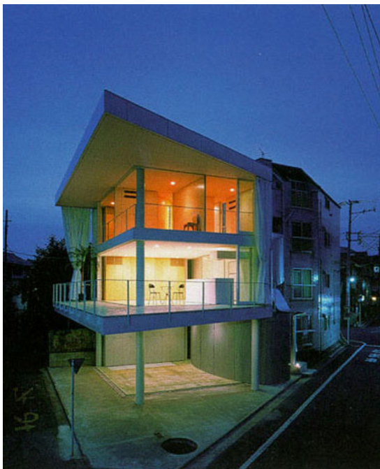
Shigeru BAN, Curtain Wall House , Tokyo, Japon, 1995 (fig. 59)
