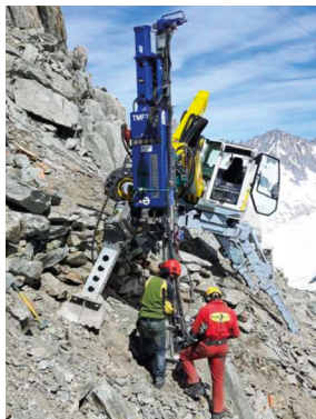
Préparation de la tête de forage avant de forer sur le versant sud de l'Aiguille des Grands Montets. 17
