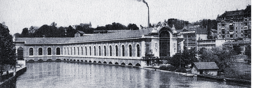
Fig 6 - Vue sur la façade ornée du Bâtiment des Forces Motrices
