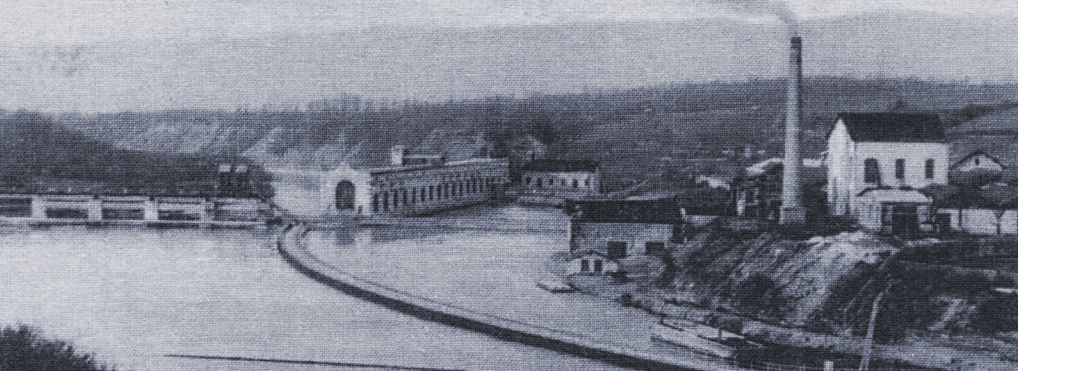
Fig 3 - Vue générale de l'usine de Chêvres
