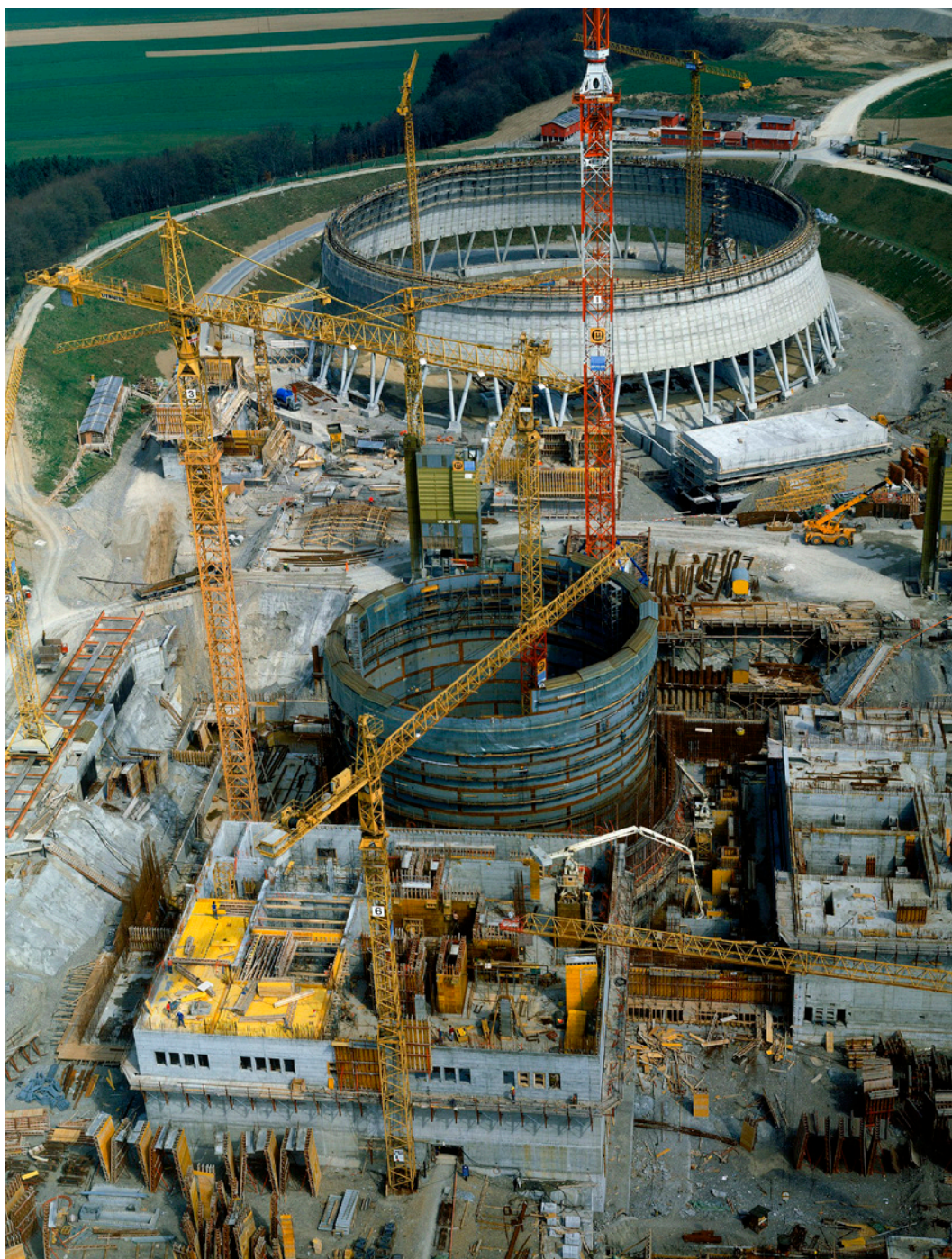
fig j. Le chantier de la centrale de Leibstadt en 1978, on peut remarquer les géometries et les techniques de construction particulières de chaque élément du complexe
