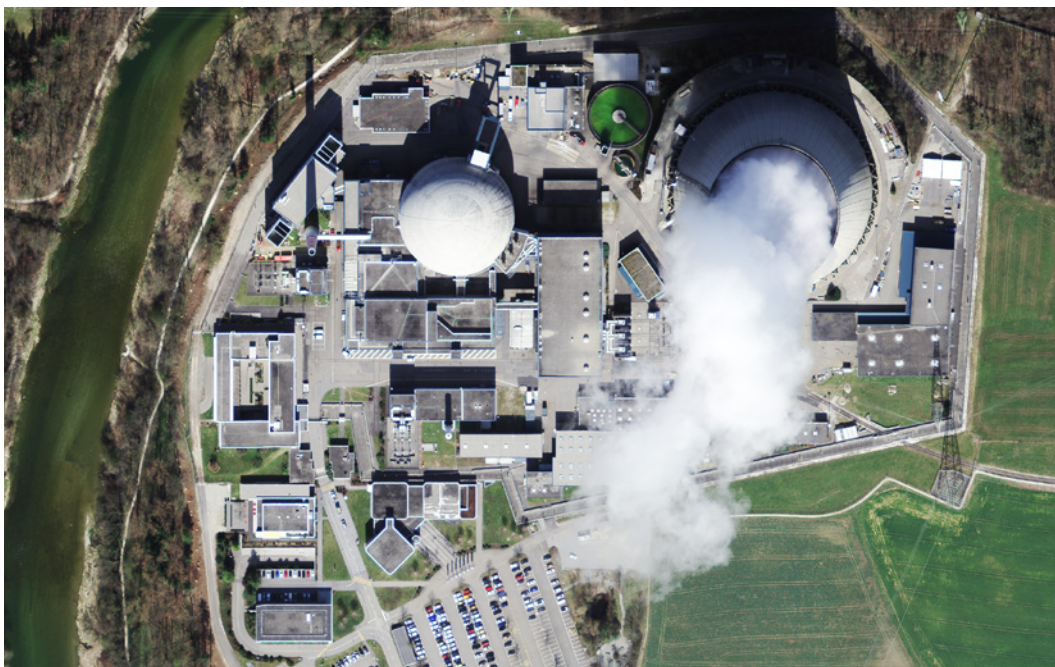
fig f. La centrale de Gösgen, avec son dôme hémisphérique et sa tour de refroidissement
