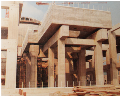
fig 1. Table en béton armé qui supporte le groupe de turbines. D'après sa source "architecture monumentale digne de la salle hypostyle de Karnak."
