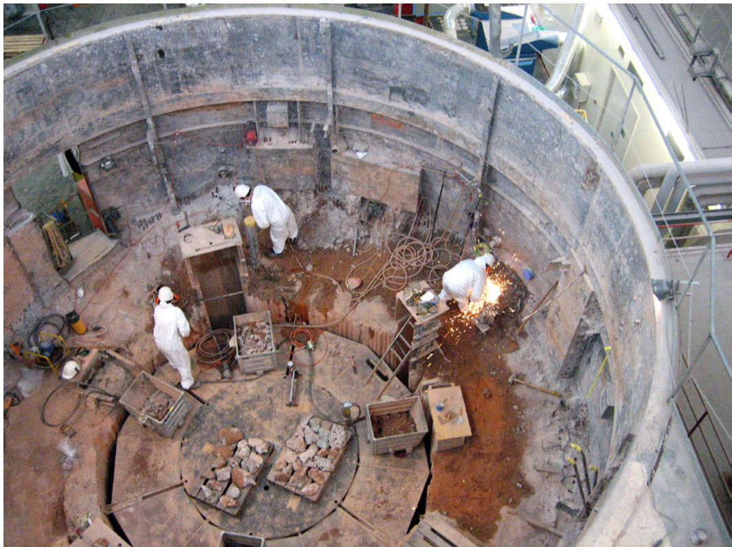
fig j. Opérations de démantèlement sur le réacteur d'essai Diorit
