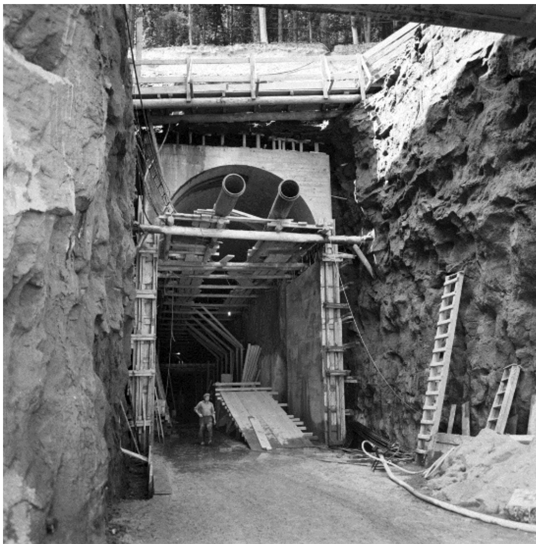
fig g. Creusement de la galerie d'accès aux cavernes du réacteur. Ces cavernes seront le tombeau du projet nucléaire suisse.
