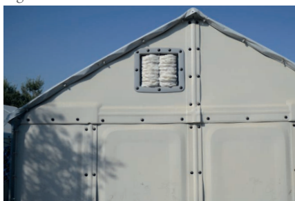
Fig. 113- Chiffon dans ventilation Better Shelter, Kara Tepe, oct. 2016 (gauche)
