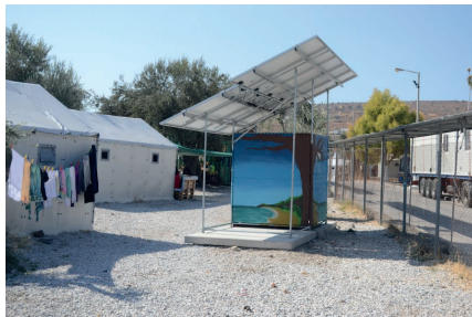
Fig. 64- Panneaux photovoltaïques, oct. 2016
