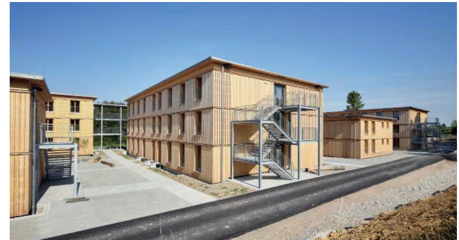
Fig. 155- Immeubles pour réfugiés à Freiburg [©Miguel Babo / Deutsches Architekturmuseum]
