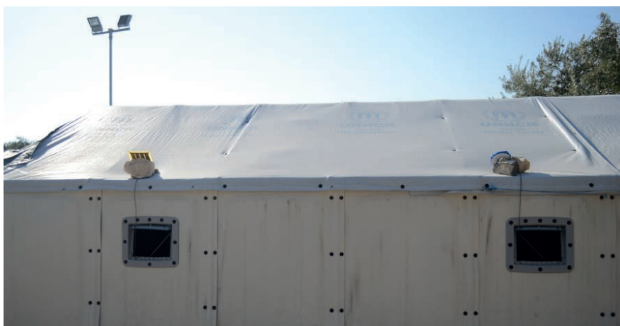
Fig. 112- Bâche sur le toit d'un Better Shelter, Kara Tepe, oct. 2016
