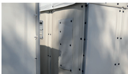
Fig. 115- Trou bouché par un panneau de façade Better Shelter, Kara Tepe, oct. 2016 (gauche)
