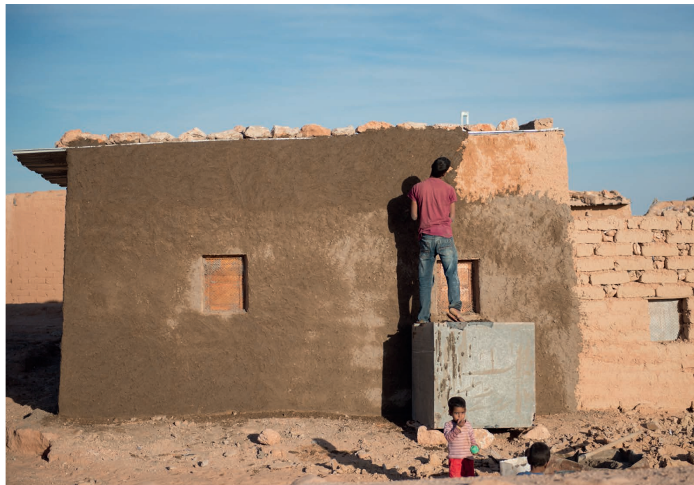
Fig. 132- Recouvrement des briques adobe par de l'enduit [©Benjamin Visinand]
