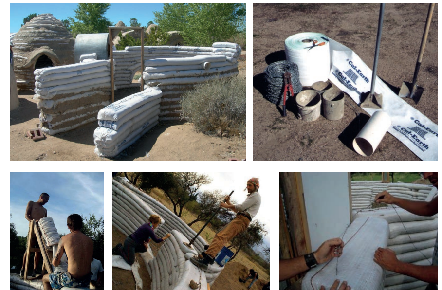
Fig. 139- Construction de l'abri [source: changera.blogspot.ch]
