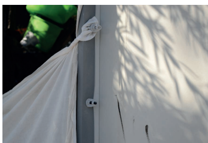
Fig. 117- Vis utilisées comme crochet sur les Better Shelter, Kara Tepe, oct. 2016
