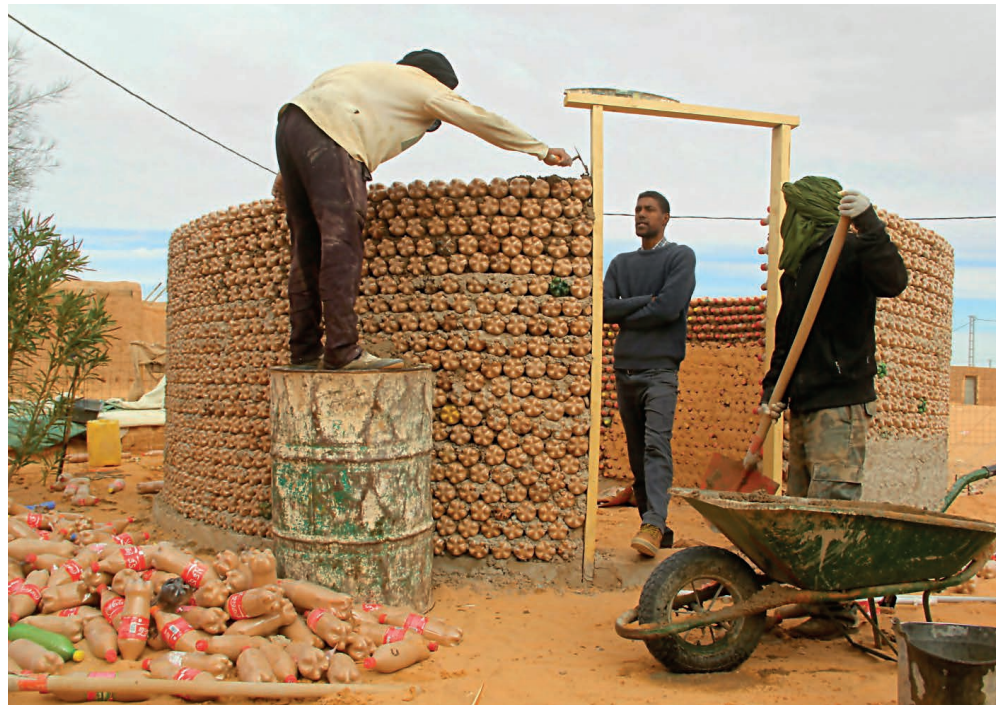
Fig. 134- Construction de la maison adobe à l'aide de bouteilles [©Habib Mohamed / Global Possibilities]
