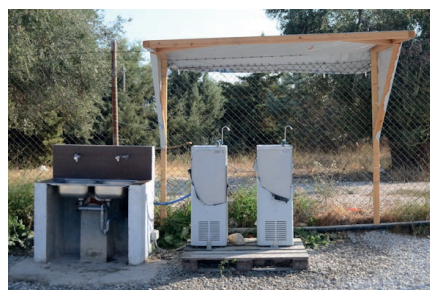
Fig. 58- Point d'eau, oct. 2016
