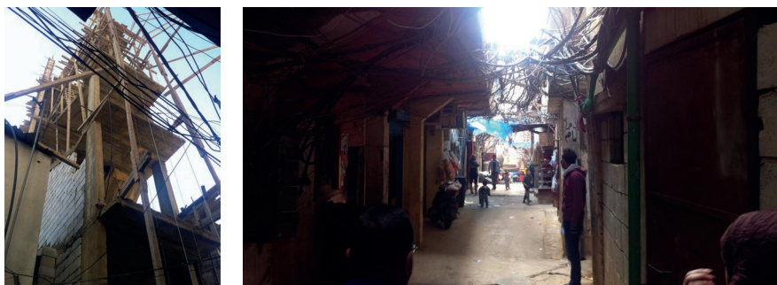
Fig. 95- Construction de bâtiments (gauche) et rue sombre (droite), nov. 2012 [©Ueli Salzmann]
