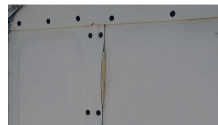
Fig. 115- Trou bouché par un panneau de façade Better Shelter, Kara Tepe, oct. 2016 (gauche)
