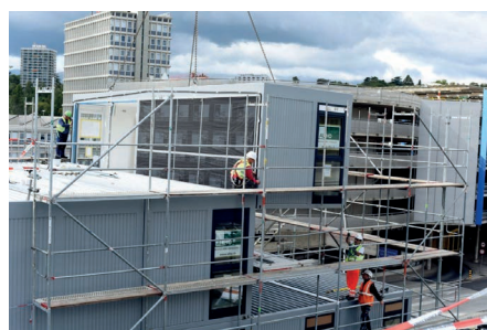
Fig. 144- Mise en place du container (gauche) [©Laurent Guiraud / La Tribune de Genève]
