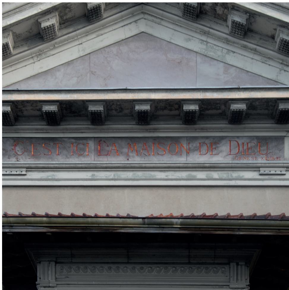
Fig. 1 Fronton de façade ouest: état actuel. Inscription d'origine « C'est ici la maison de Dieu, génèse XXVIII. 17.»
