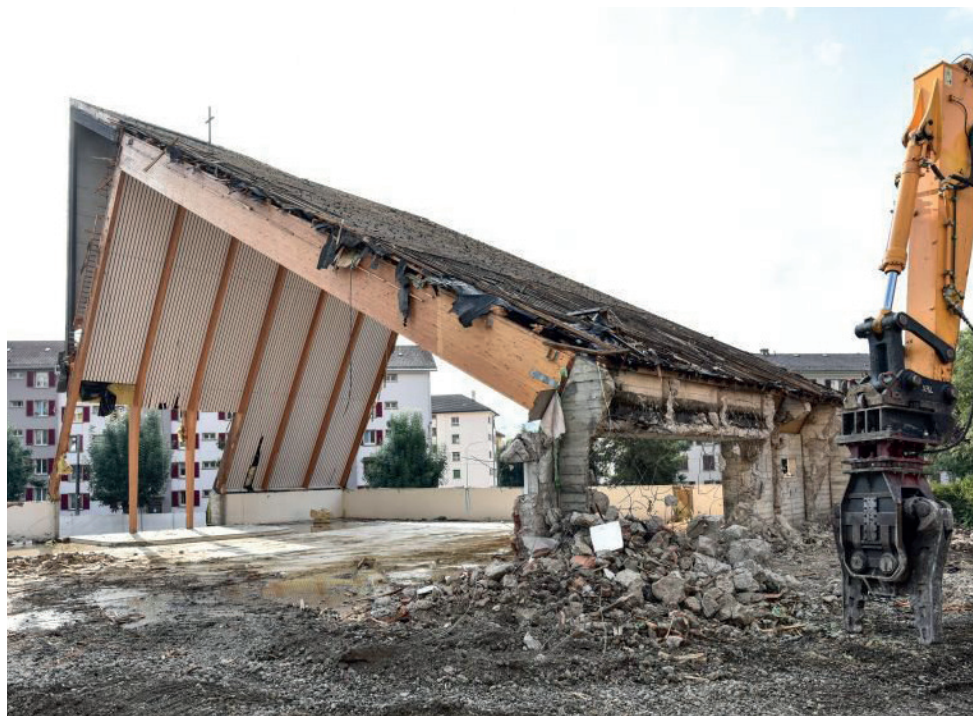
Fig. 1 Destruction du temple des Forges, Chaux-de-fonds, 2016.
