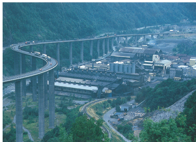
2. Rougier, Le viaduc des Egratz, 2005
