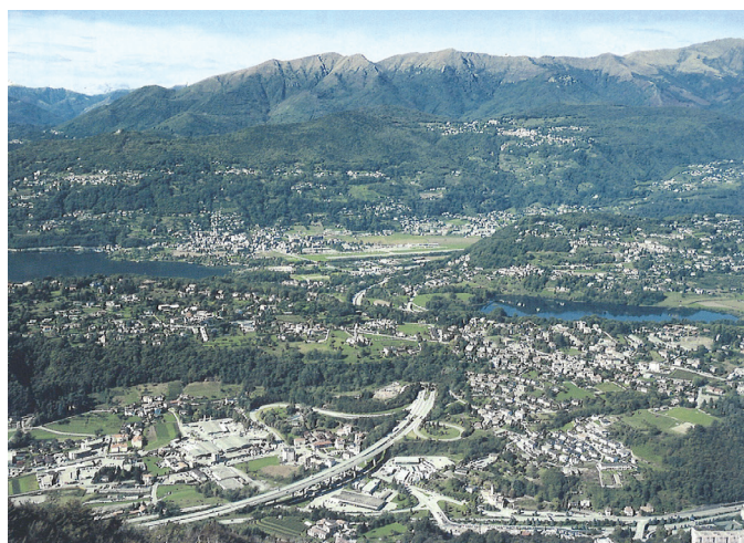
9. Bätzing, Autoroute du Gothard près de Lugano, 2005
