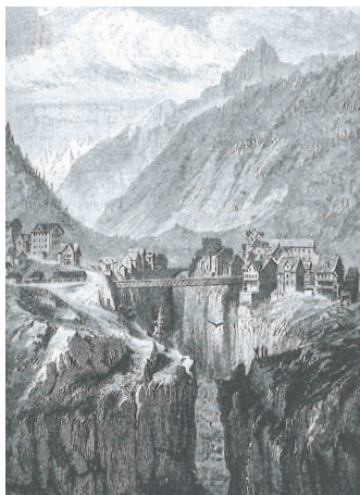
5. The Saint Gothard Railway, Göschenen, s.a.
