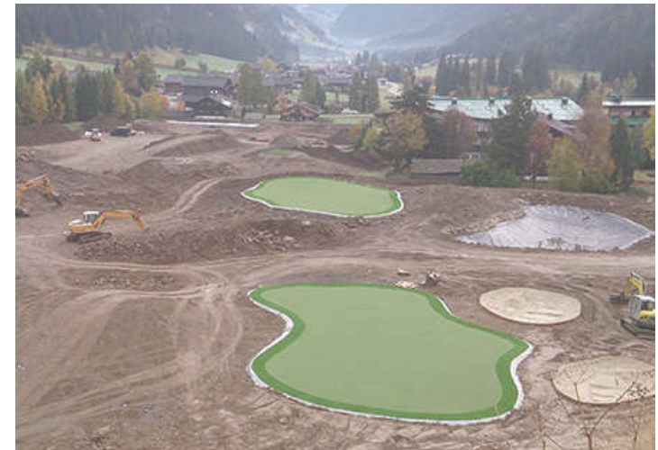
Fig.13: Construction d'un terrain de golf dans la vallée du Girolino, Italie (2007)
