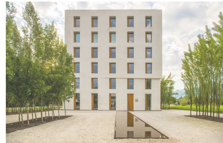
Fig.6: Bâtiment intégralement automatisé pour toujours être entre 22 et 26 degrés, BE Architekten (2013)
