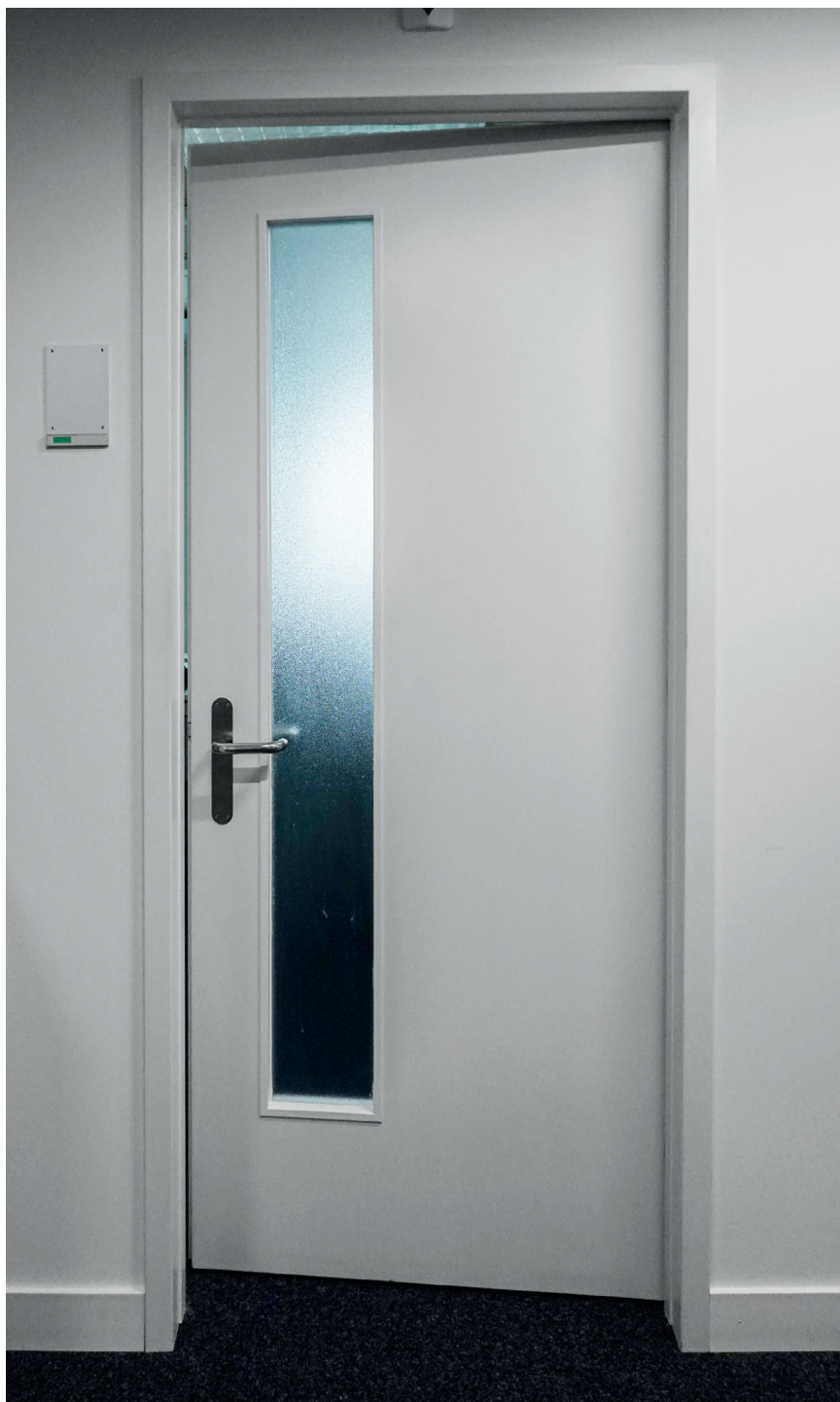
PORTE DE RÉEMPLOI, NIVEAU 5
