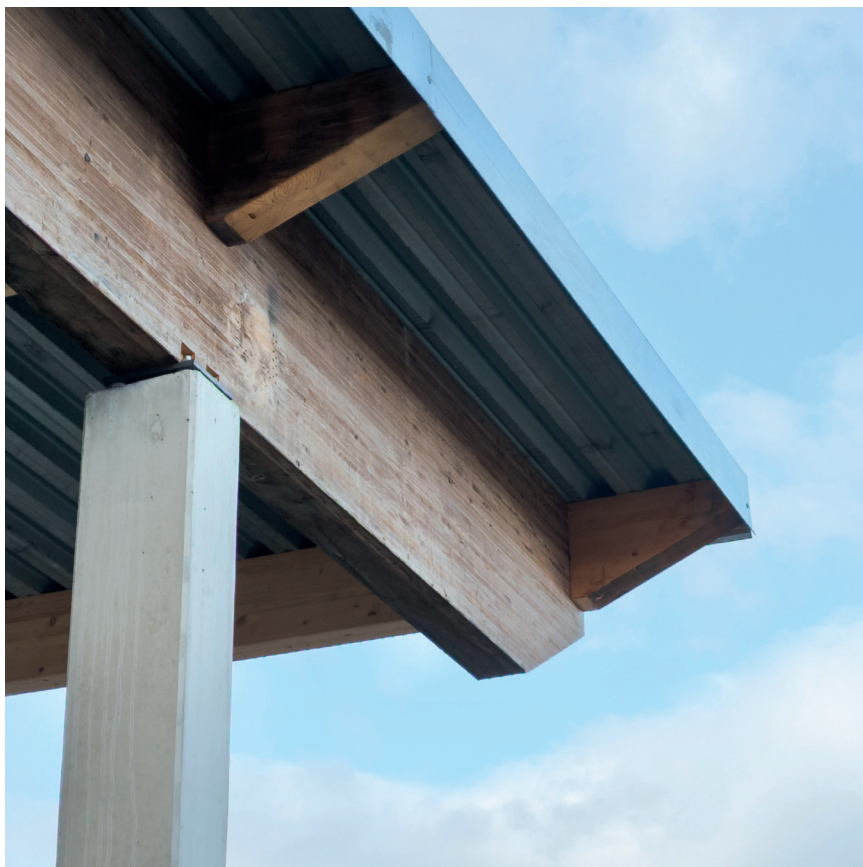
COUVERT EXTÉRIEUR, EN BOIS ET TÔLE DE RÉEMPLOI
