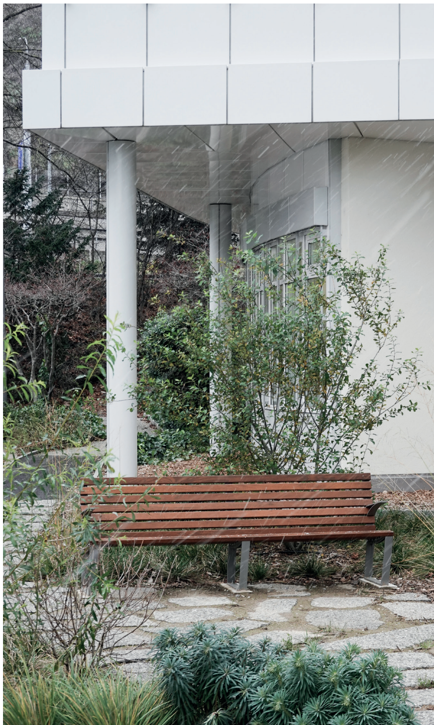
AMÉNAGEMENTS EXTÉRIEURS, ENROBÉ DE RÉEMPLOI
