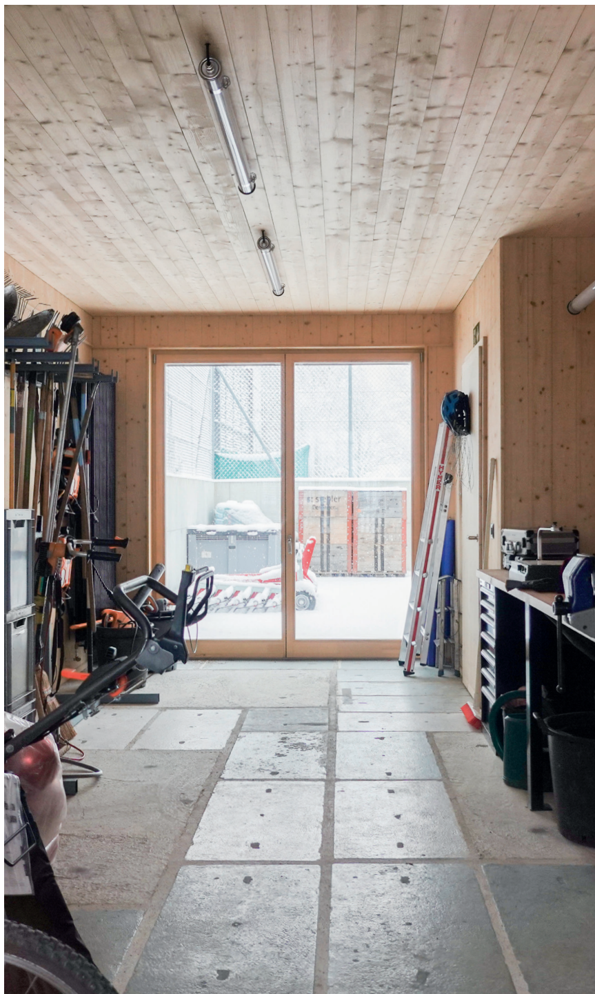
REZ-DE-CHAUSSÉE, DALLES DE RÉEMPLOI AU SOL
