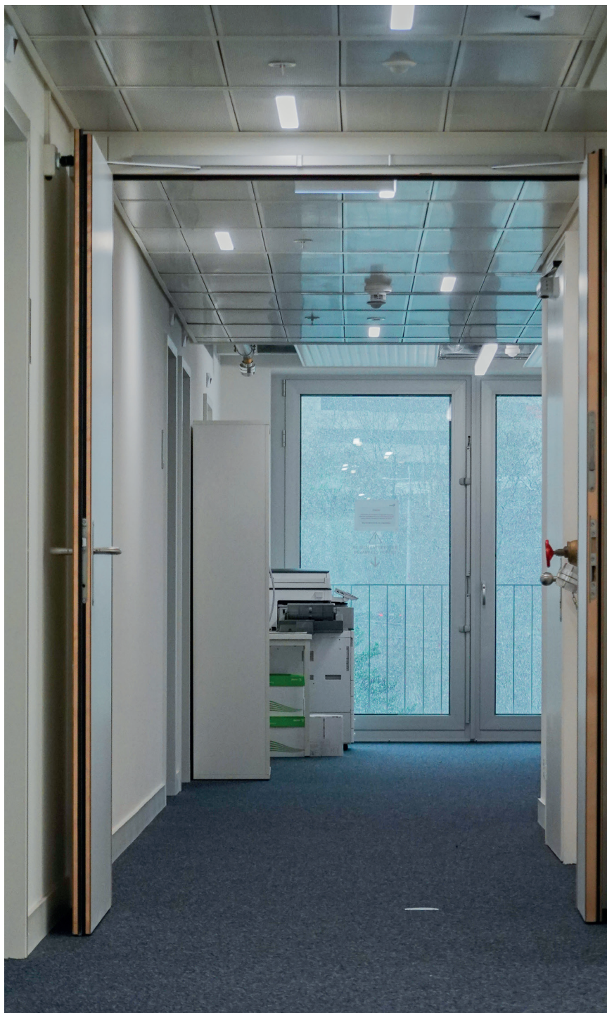
COULOIR DE LA TOUR, FAUX PLAFONDS DE RÉEMPLOI, NIVEAU 5
