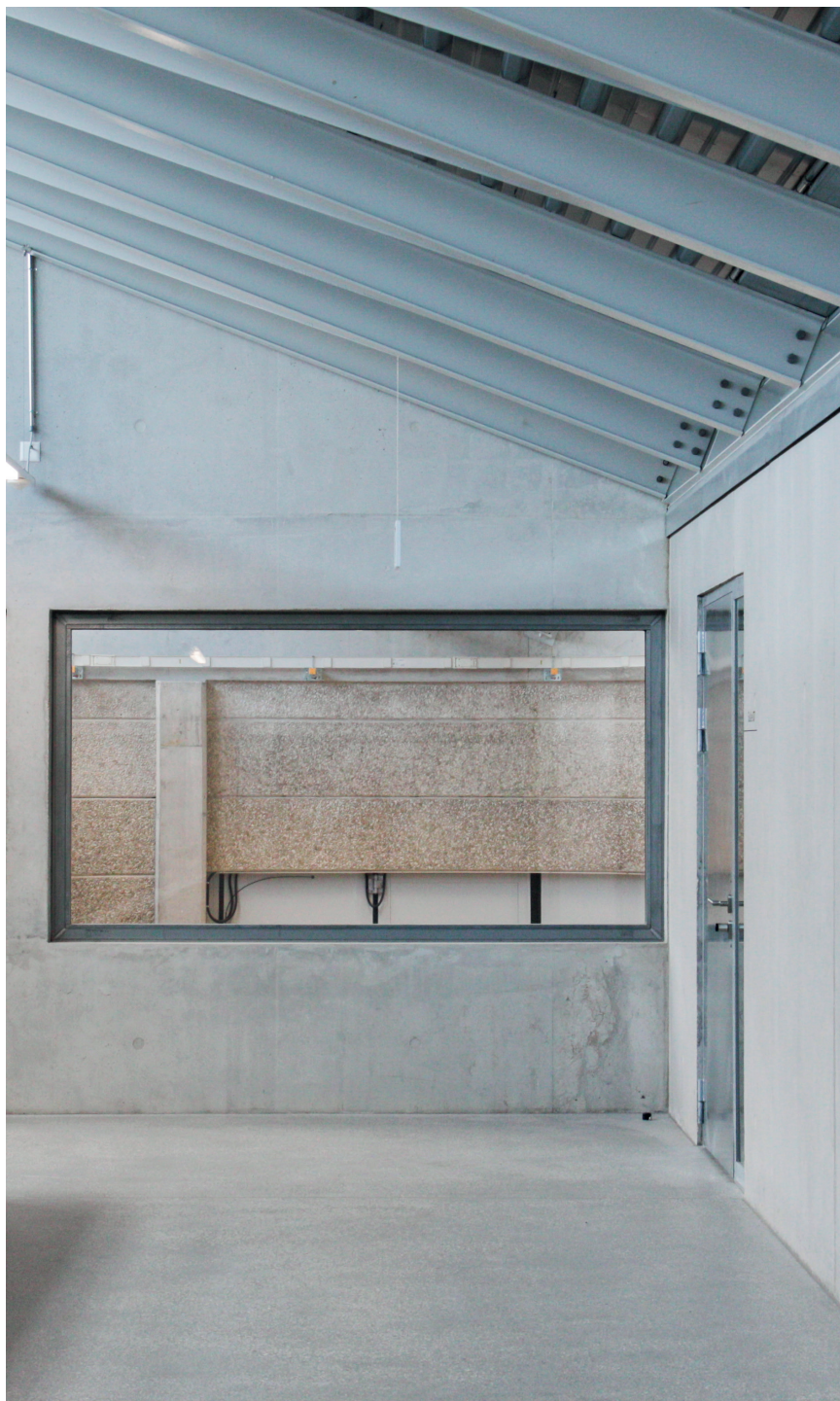
GALERIE SUPÉRIEURE, VUE SUR LES ÉLÉMENTS EN BÉTON DE RÉEMPLOI DE LA HALLE EST
