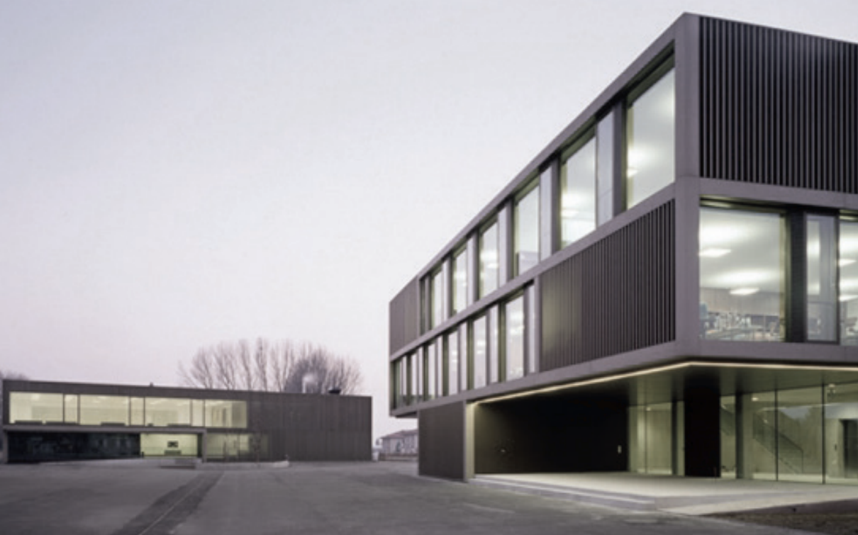
Le centre scolaire de Cheseaux-sur-Lausanne.
