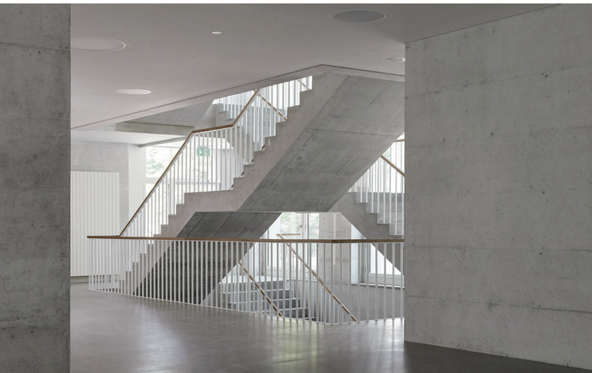
Escaliers et finitions intérieures en béton brut.
