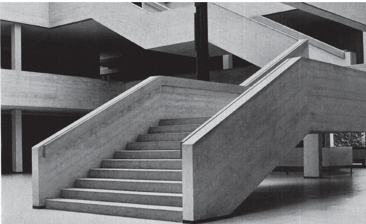
Vue rapprochée de l'escalier en béton.
