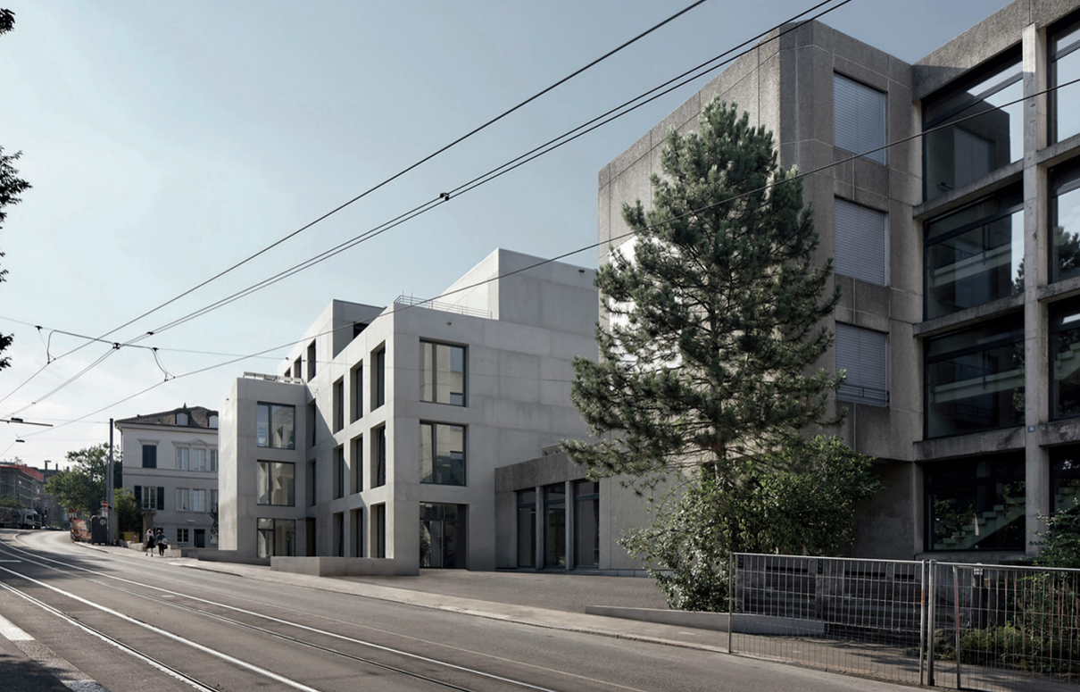
Vue du bâtiment existant et de son extension.
