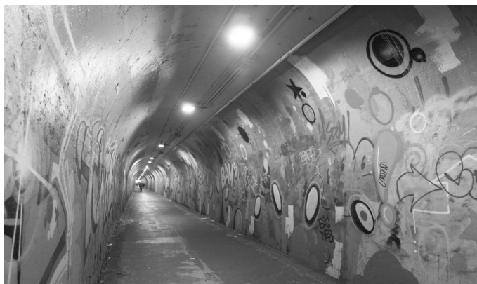
Tunnel d'accès à la station 191st Street
