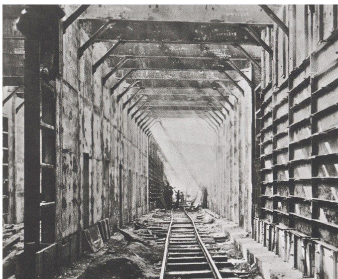
Construction de la ligne BRT, 60 th street et 4 th Avenue, 1915
