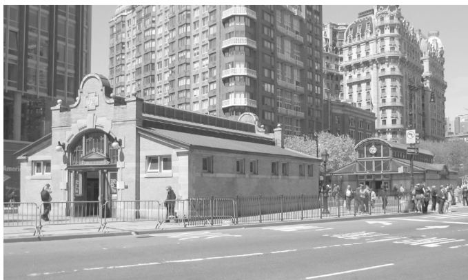
Pavillon d'entrée de la station 72nd Street IRT
