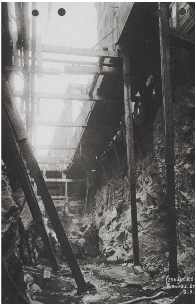
Construction utilisant la tech- nique du "cut & cover", archives du MTA
