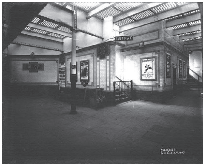
Prise de lumière naturelle dans l'ancienne station 18th Street
