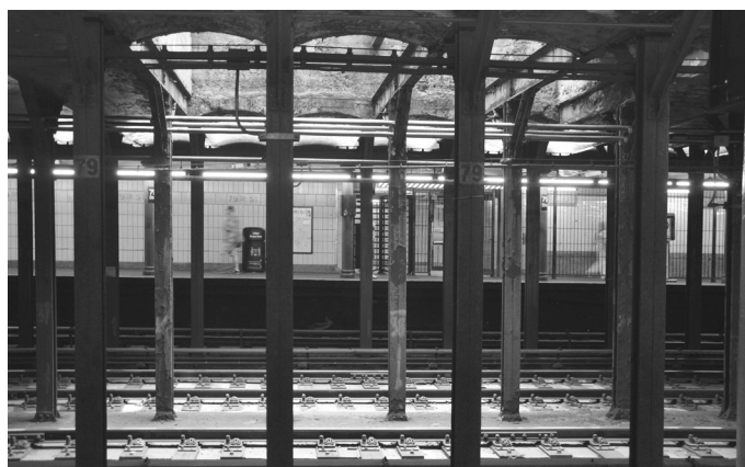
Prise de lumière naturelle dans la station 79th Street
