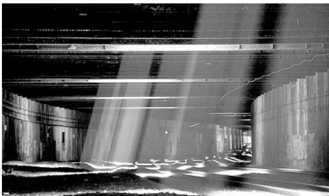
Freedom Tunnel sous Riverside Park
