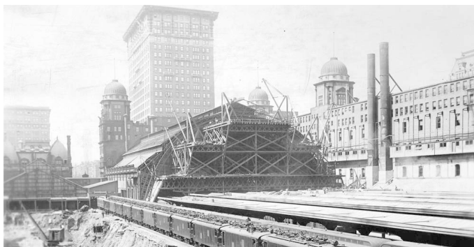
Destruction du vieux couvert et travaux souter- rains pour les nouvelles voies, 1908
