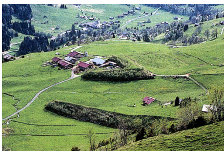
34. Schoeneich P, digues de protection contre les avalanches au Lavanchy
