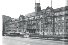
Polizeipräsidium Frankfurt an der Friedrich-Ebert-Anlage, 1909 Police Headquarters at Friedrich Ebert Anlage (1909)
