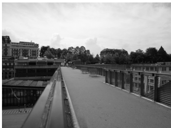
Passerelle du Flon
